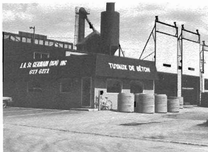
1985 - Usine de fabrication de tuyaux de béton au même endroit
