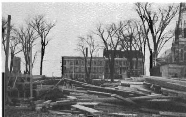
Début de construction de l'Académie Ave Maria, mars 1952
