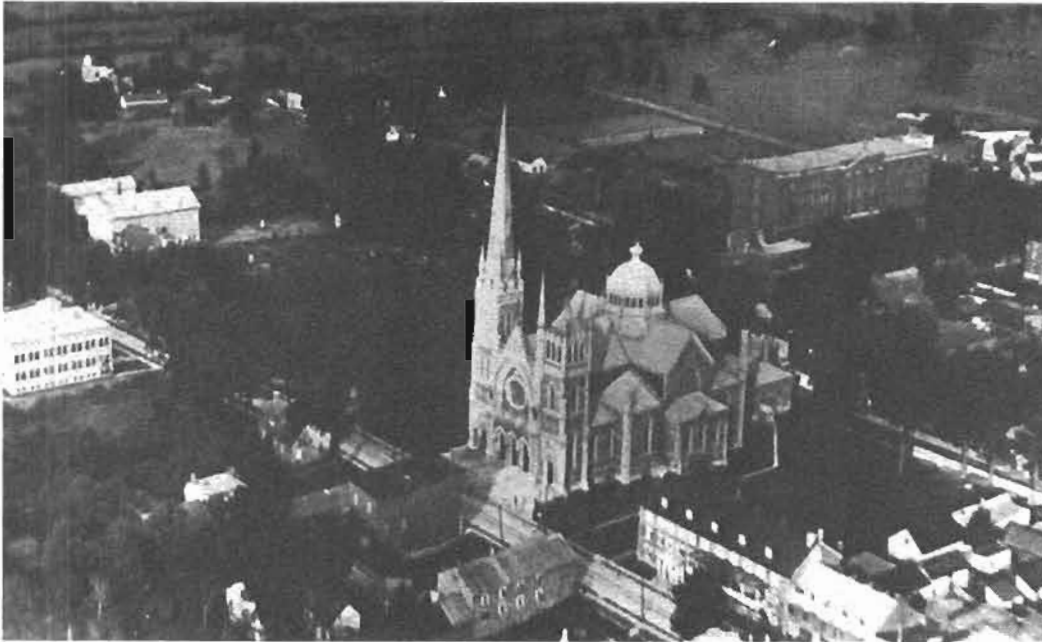
Co-Cathédrale Sise aux coins de la rue Saint-Charles et du chemin de Chambly, la Co-Cathédrale Saint-Antoine-de-Padoue fut érigée en 1885. La première église paroissiale achevée en 1727, fut remplacée par l'église de 1811, à son tour supplantée par l'actuelle Co-Cathédrale. On imagine facilement les futurs Hubertins, au sortir de la messe le dimanche, regagner leurs terres par le chemin de Chambly (Photo aérienne prise en 1920)
