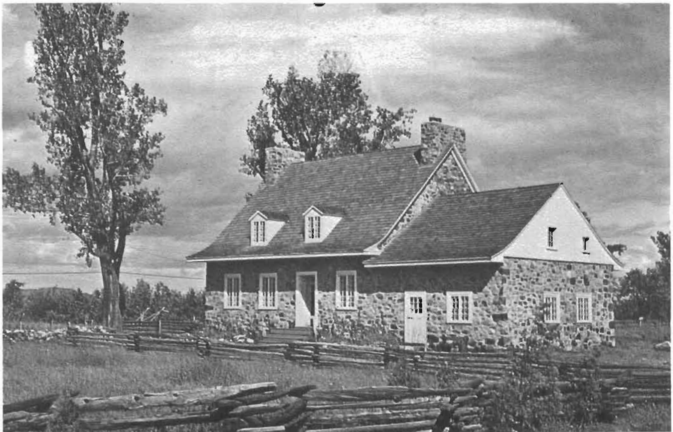
Cette bâtisse serait la première école de la Municipalité scolaire de Saint-Hubert. On l'appelait à l'époque l'École Modèle
