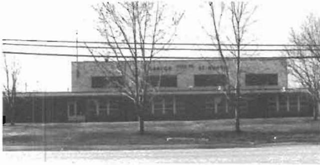
Garage municipal, rue Maricourt
