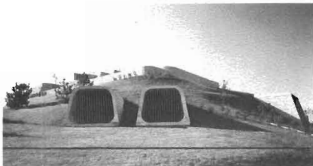
Station de pompage. Témoin prestigieux du «partnership» régional, la station régionale de pompage d'eau brute, sise rue Saint-Charles ouest, a été inaugurée en 1982 et a reçu en 1983, le prix d'architecture du Gouverneur général du Canada. Les eaux tirées du fleuve sont par la suite acheminées vers l'usine régionale d'épuration, qui dessert les villes de Saint-Hubert, Boucherville et Saint-Bruno.
