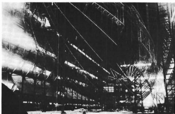
Le 2 décembre 1931, on commençait la démolition du R-100.
