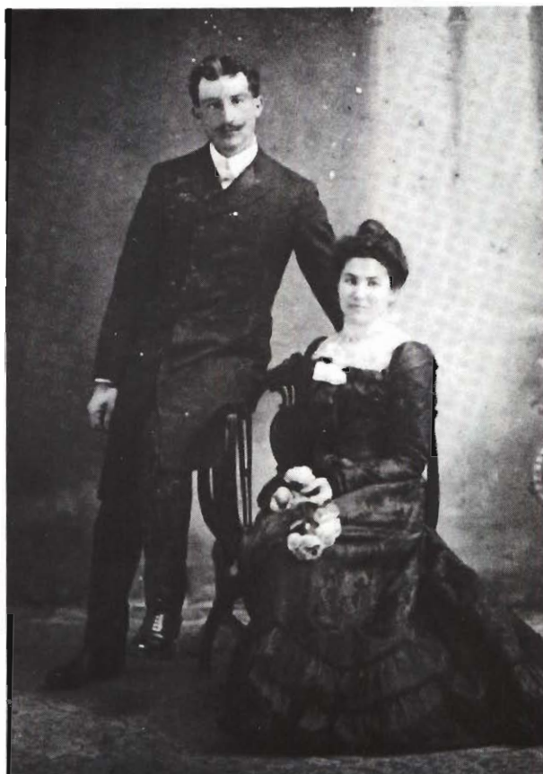
M. Henri Rocheleau, contremaître lors de la construction du mât.
