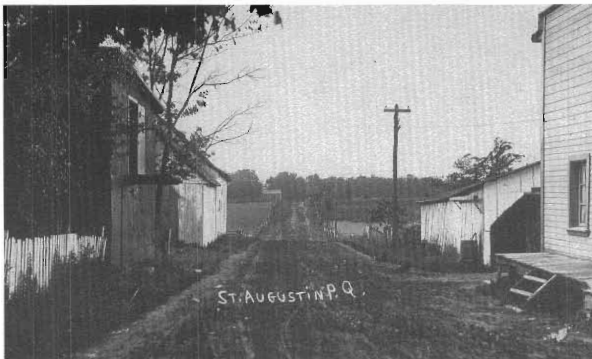
Rue St Jacques (chemin du dépôt) à l'intersection Saint-Augustin
