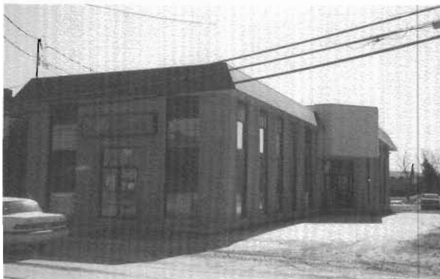
Vue extérieure du siège social 1990
