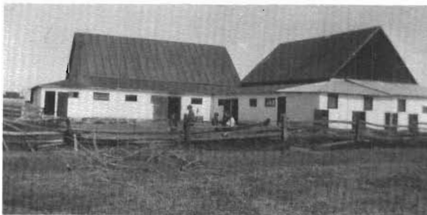
Les bâtiments de ferme du Petit-Brûlé en 1933
