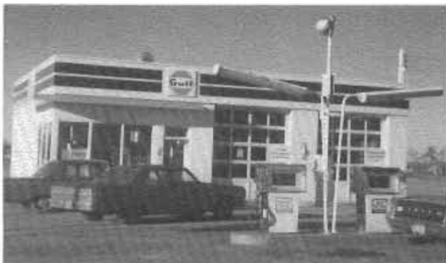
Emplacement de la station de service, coin Route 148 et rang Saint-Étienne
