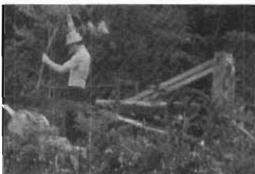
Photo prise à l'occasion de la Saint-Jean. Remarquez M. Raymond Leduc en train d'ajuster une bûche de 4 pieds de diamètre prêt pour le sciage. On aperçoit un mécanisme, mieux connu sous le nom de "godendard", mis en fonction par un bicycle à pédale. Gracieuseté de René Labelle
