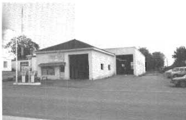
Photo du "Garage Thérien", entreprise effectuant travaux de mécanique, de peinture et de débosselage
