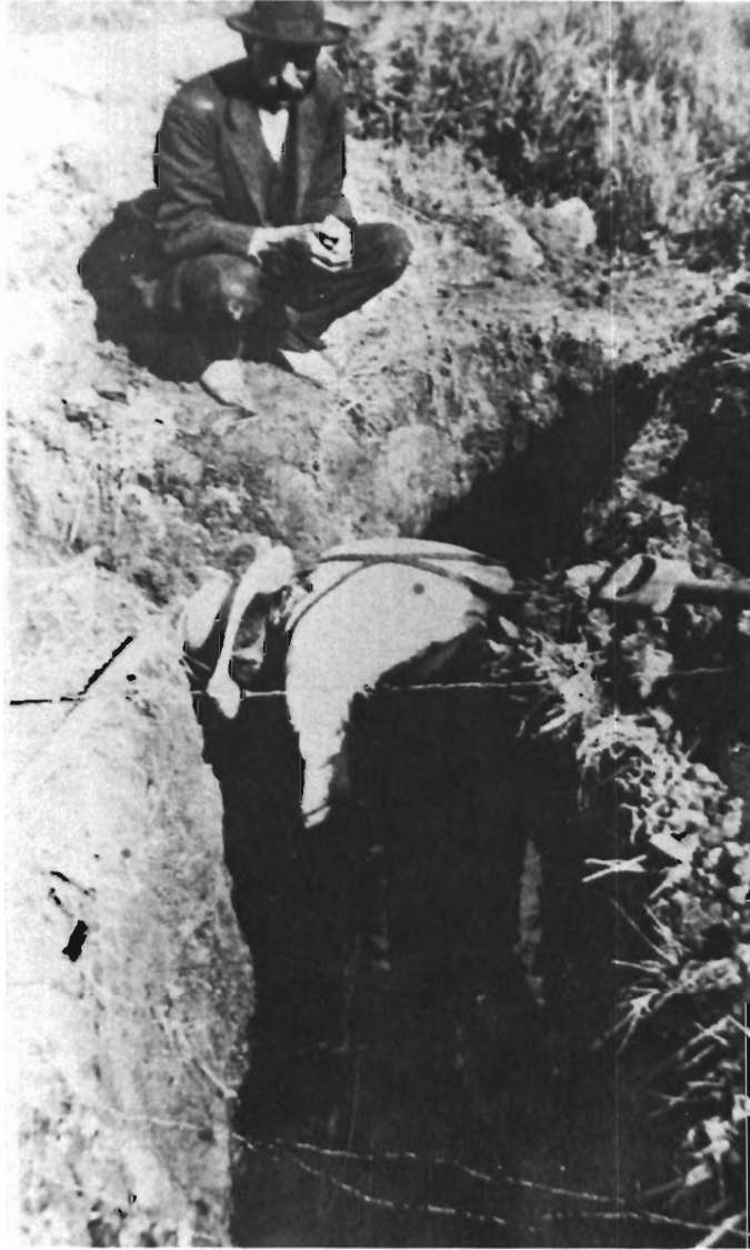
Aqueduc du village 1906 Victor Bergeron surveillant les travaux.
