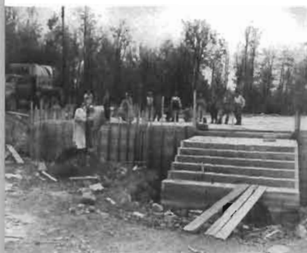
La construction du monastère des Recluses Missionnaires.
