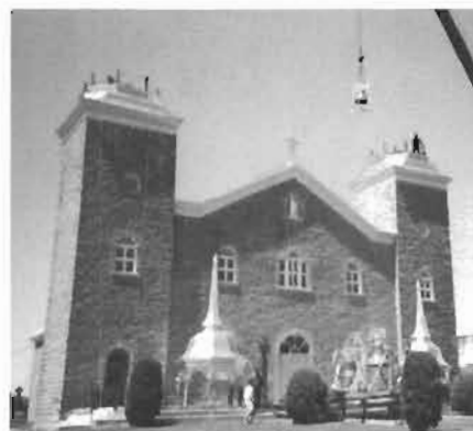
Saint-Hermas. Réparations des clochers de l'église.
