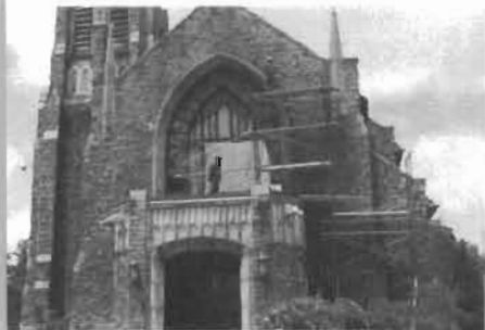
Saint-Julien de Lachute. Travaux à l'extérieur de l'église.
