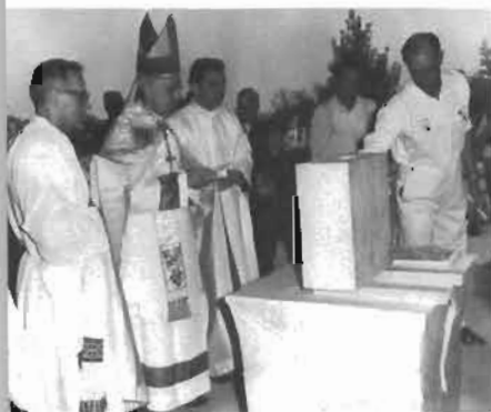
Saint-Pierre de Saint-Jérôme. Bénédition des travaux de construction de l'église. Assistent M gr Frenette, le chanoine Maurice Théoret et l'abbé André Martineau.
