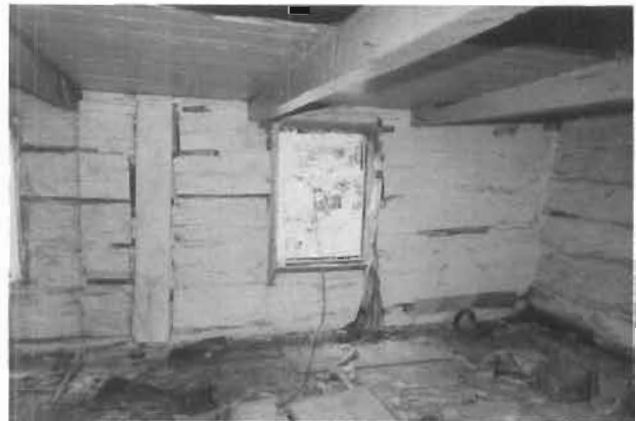
301. L'intérieur en 1985. Remarquons l'épaisseur des pièces et leur recouvrement à la chaux. D. (C.B.)
