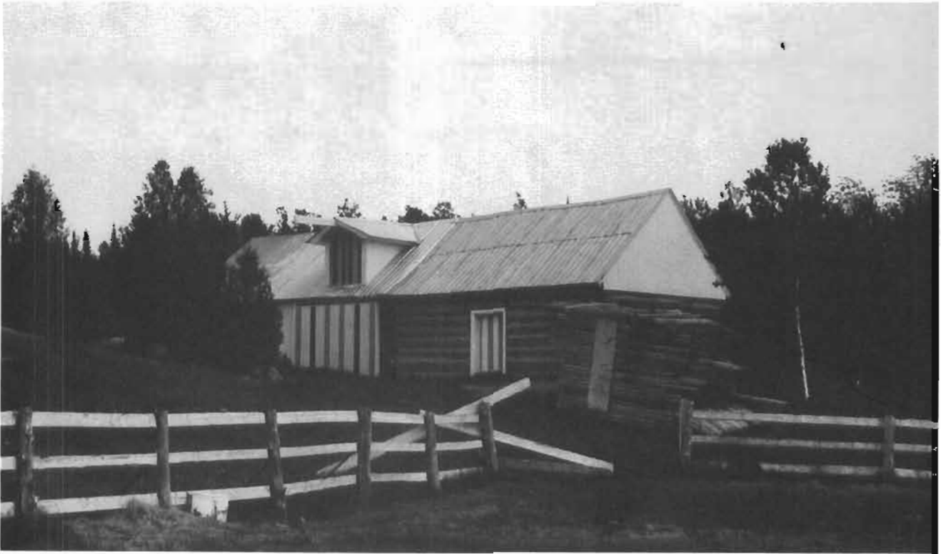
230. Grange-étable en pièces, ferme Ernest McAndrews, côte Saint-Nicholas ouest. (C.B.)
