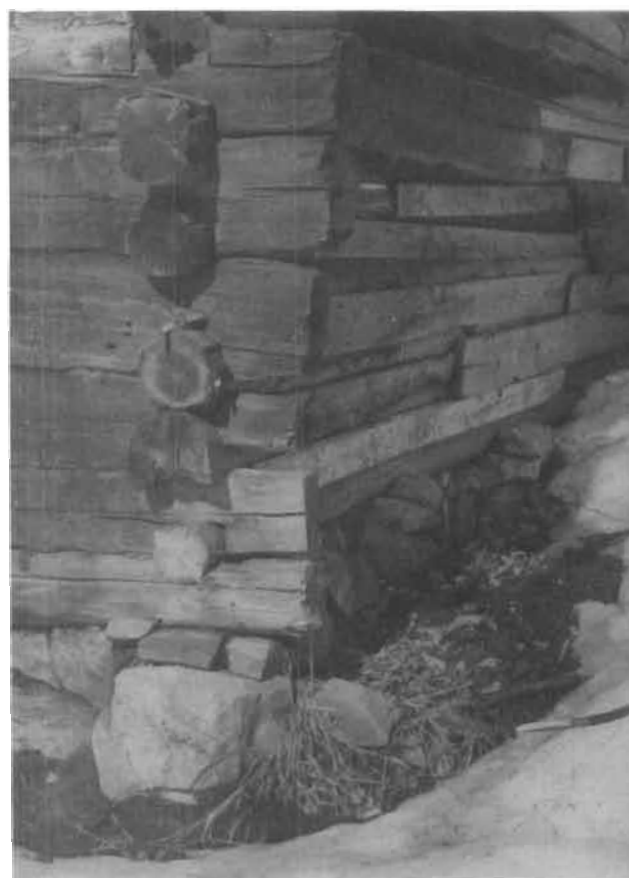
186. Assemblage par encochements concaves, dépendance maison Albert Raymond, côte Saint-Paul est. 1983. (C.B.)
