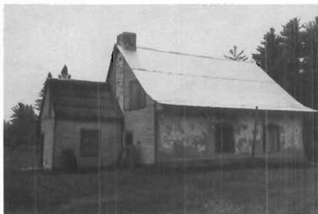
286. Vue ancienne de l'arrière. (I.B.C.)
