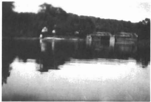
135. L'ancien pont MacKenzie reliant le village de Saint-Canut à Saint-Colomban. 1920. D. (C.P.)
