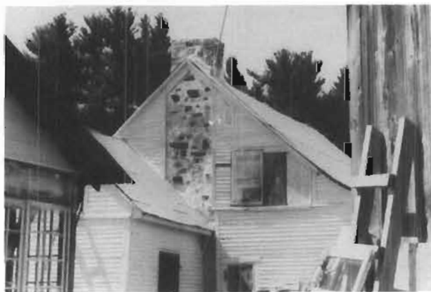
204. La cheminée de la maison F. Crevier fait partie intégrante du mur de pièces comme l'immense majorité des maisons anciennes de Saint-Colomban. (C.B.)
