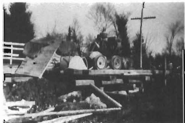
136. La construction du pont actuel. (C.P.)
