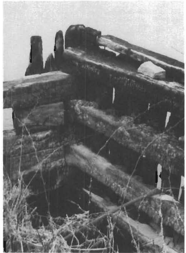
132. Vestige du pont couvert. 1983. (C.B.)
