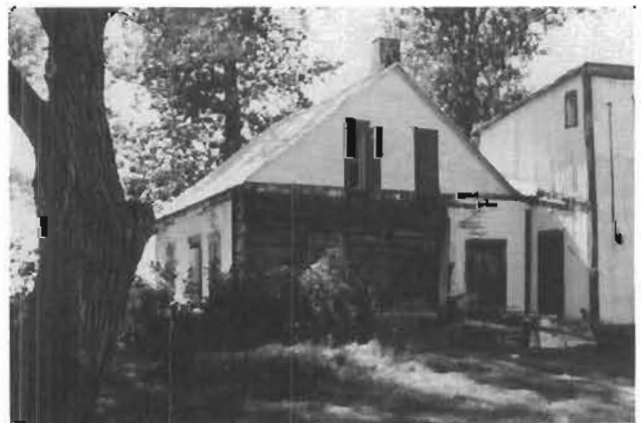
311. Maison Black au moment de sa démolition en 1978. Elle se trouvait coin montée Brisebois/chemin de la rivière du Nord ouest, au lieu-dit: Gordonville . D. (A.B.)
