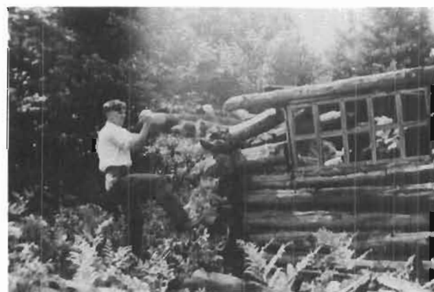
87. Démolition du vieux camp Vaillancourt. 1943. D. (C.P.)
