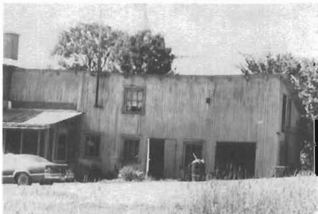
158. Le hangar attaché au presbytère avant sa rénovation. (C.B.)
