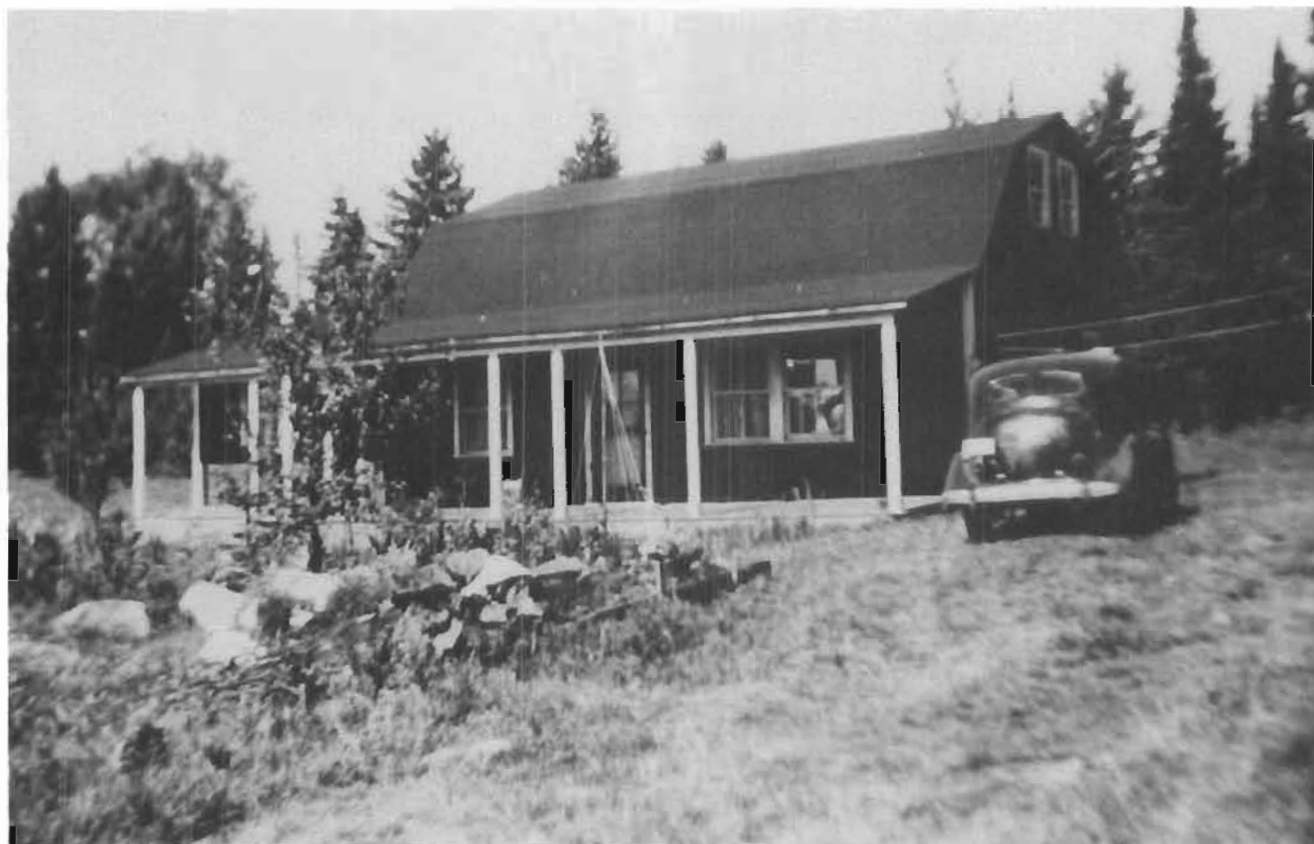
210. Maison de type mansarde à deux brisis. Maison Cooper, côte Saint-Paul ouest. D. (C.P.)
