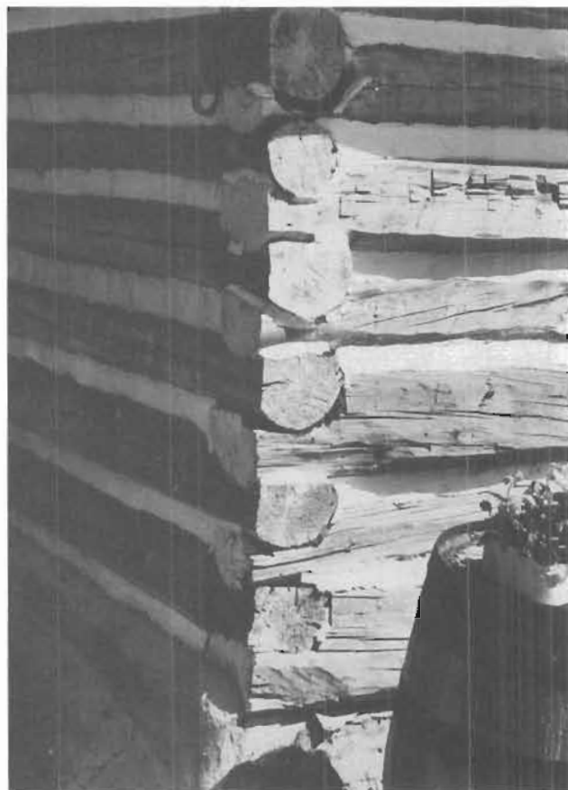
185. Assemblage par encochements ouverts, Villa Antique, chemin de la rivière du Nord est. (C.B.)
