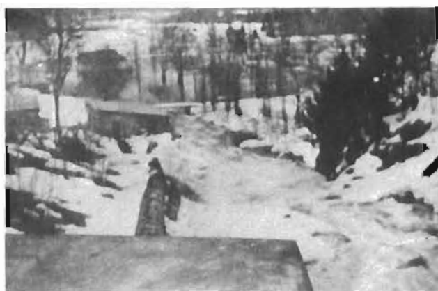
77. Autre vue cette fois à partir du barrage. À remarquer le tuyau de bois servant à acheminer l'eau à la centrale. D. (C.P.)
