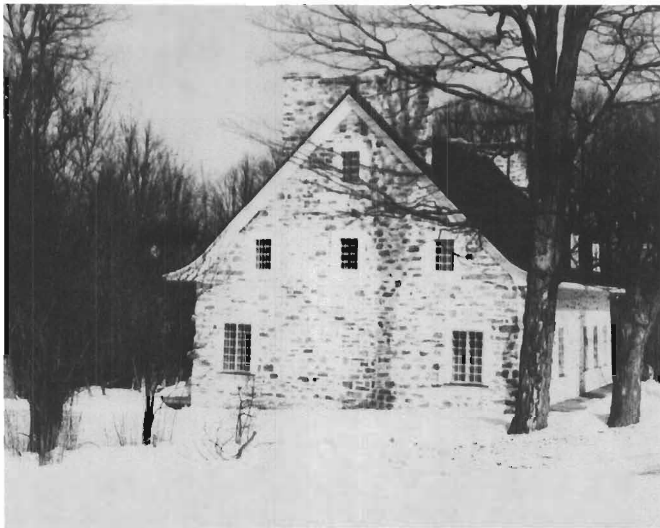
17. Bureau seigneurial des Sulpiciens à Belle-Rivière. Ce magnifique bâtiment existe toujours. (C.B.)
