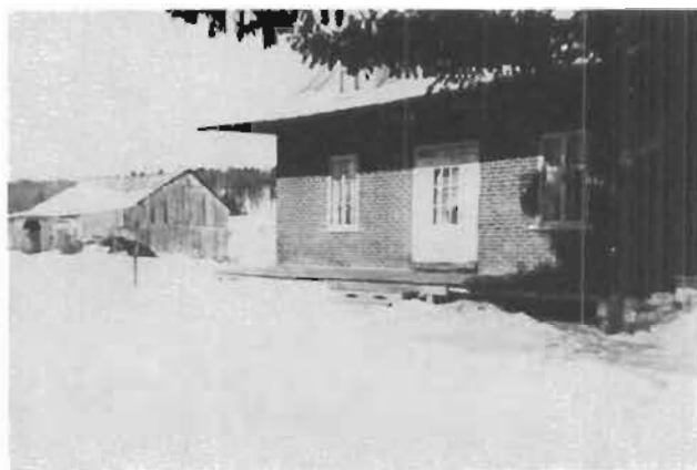
314. Ferme Kavanagh, vers 1930-40. Grange démolie. (C.P.)
