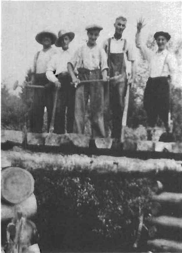
134. L'ancien pont Melloy lors de sa construction. De gauche à droite: Omer Brisebois, Henri Labelle, Charles Labelle, John Kenna, Marcel Labelle. Vers 1945. (C.P.)
