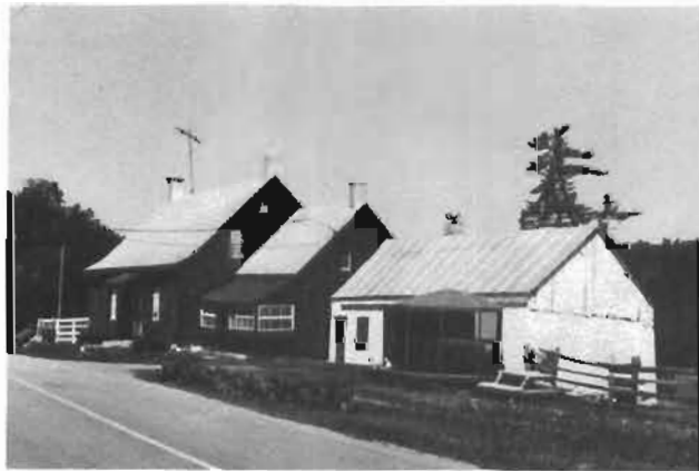
317.-318. Ferme Deschambault anciennement Power. Selon un marché de construction daté du 2 novembre 1847, cette maison aurait été construite par Hyacinthe Leblanc pour John Power. (F.P.M.A.C.) et (C.B.)
