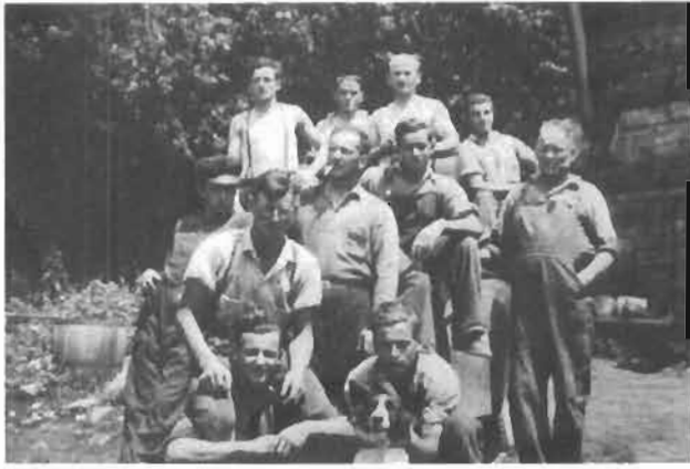
97. Chantier McCabbé. (C.P.)
