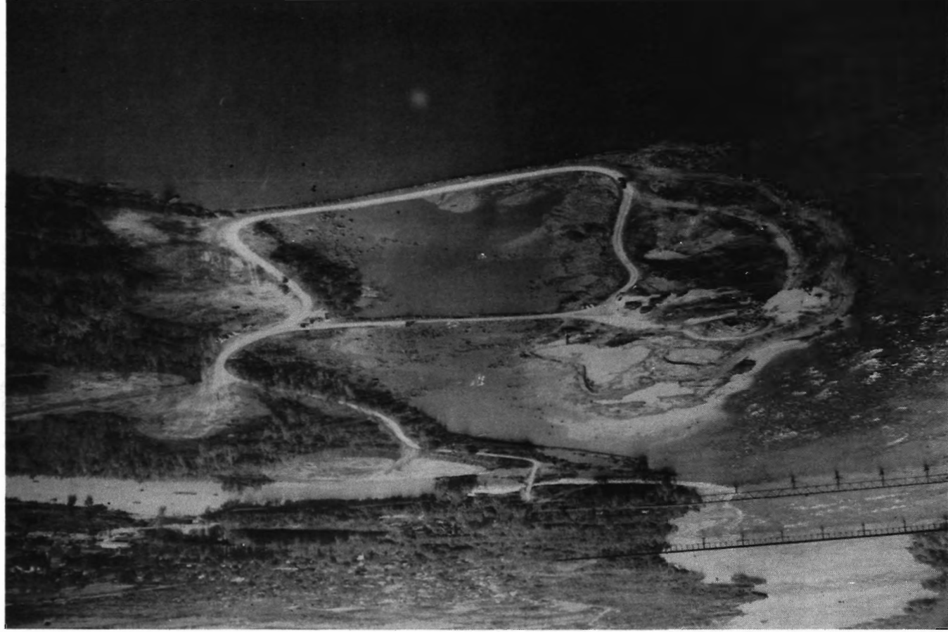
Vue des travaux effectués en face de Grenville pour enlever une île de l'Outaouais. On peut aussi voir les rapides qui existaient avant l'élévation du niveau d'eau par le barrage de Carillon. Le pont Perley n'avait pas encore été surélevé et le pont du CN n'était pas enlevé.
