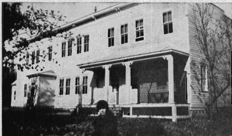
Couvent des premiers jours, détruit. La première école, à laquelle on ajoutait une résidence pour religieuses en 1923. Le tout fut détruit dans l'incendie de 1943.
