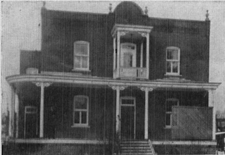
Presbytère. Construction en brique contenant 15 appartements.
