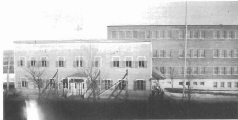
L'Institut Familial en construction. L'Ecole Ménagère vit ses derniers jours. Le vieux couvent fut démoli en 1951. Bénédiction solennelle de la nouvelle Ecole Ménagère de Nominique, "l'Institut Familial" le 4 juin 1951 par M. le curé Perreault.
