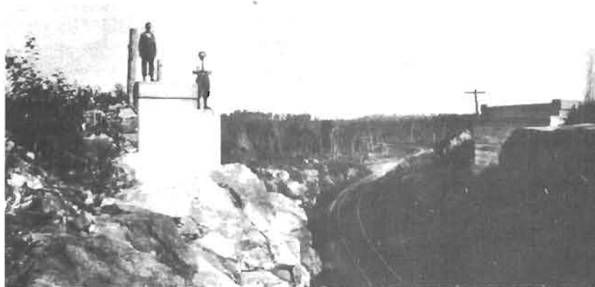
La construction d'un viaduc au-dessus de la voie ferrée, à Bertram, sur la route menant au Lac Saguay.
