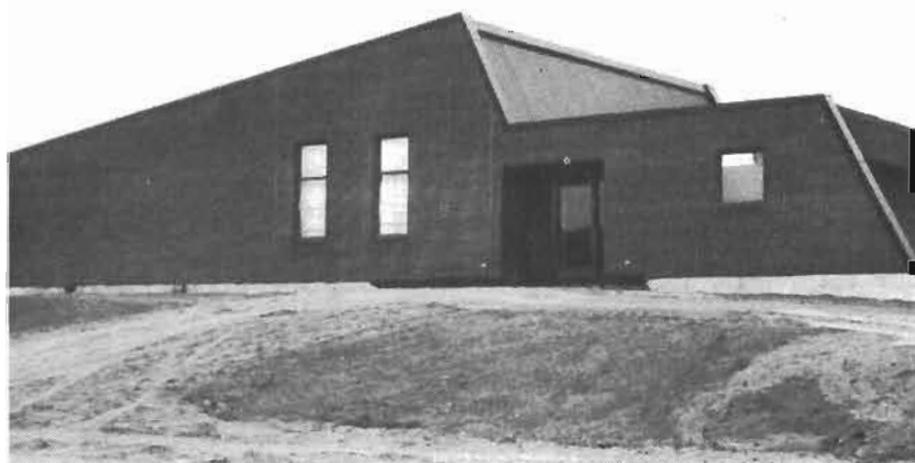
Le Centre Communautaire de Nomingue, réalisé en fonction d'un lieu de rencontre et de centre de loisirs est situé à l'entrée du village sur la route 321 à proximité de la caserne des pompiers, utilisée comme Hôtel de Ville.
