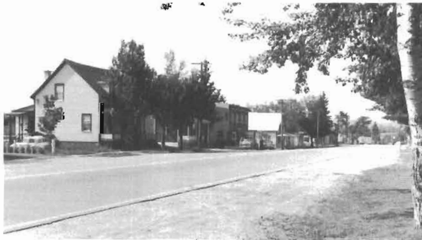
Le village a fait toilette, ses rues sont maintenant recouvertes d'asphalte.
