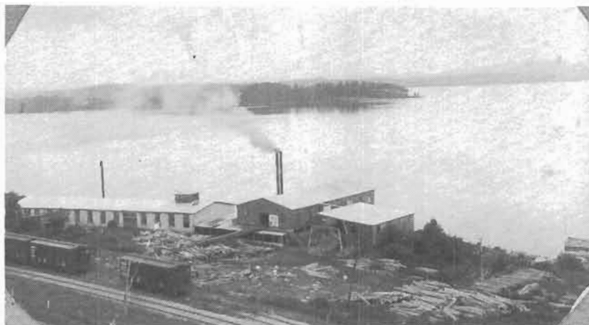
La manufacture de vener de M. Sem Lacaille à Bellerive; elle était située entre le Grand Nominuingue et la voie ferrée du Canadien Pacifique; en arrière plan se profile la Pointe des Jésuites ou Pointe Manitou.
