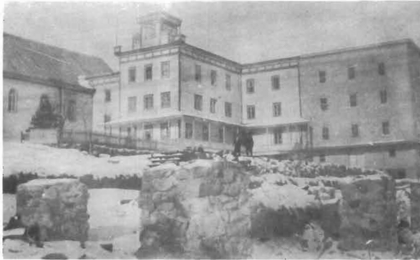
Ruine du Pavillon des classes du Collège Nomingue. Le Pavillon (1912-1913) était une construction indépendante du Monastère et situé sur la rue St-Ignace.
