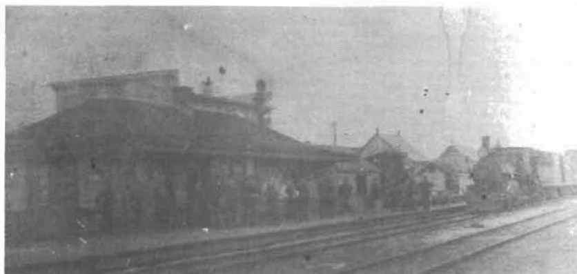
Terminus de la ligne du Nord du Canadien Pacifique, la gare de Nominuingue. On aperçoit à l'arrière-plan "la Maison du Colon", à la droite de la gare les entrepôts, hangars, forges et maisons des employés.
