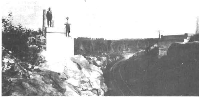
La construction d'un viaduc au-dessus de la voie ferrée, à Bertram, sur la route menant au Lac Saguay.
