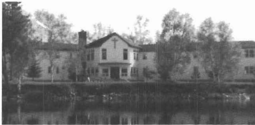
Accueil Notre-Dame du Lac situé sur les bords du Petit Nominique, construit en 1961. Destiné à être une maison de vacances pour les Religieuses, l'immeuble est transformé pour répondre aux besoins du diocèse.
