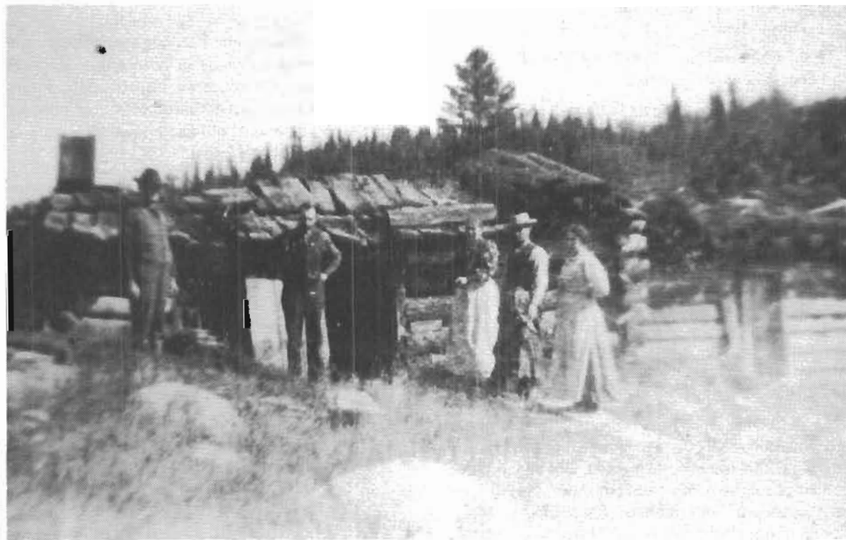
Le premier chantier du Rapide-de-l'Original
