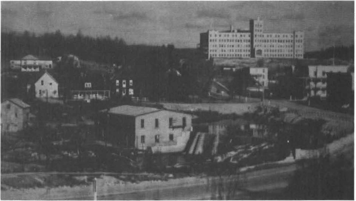
L'usine électrique au rapide de l'Original
