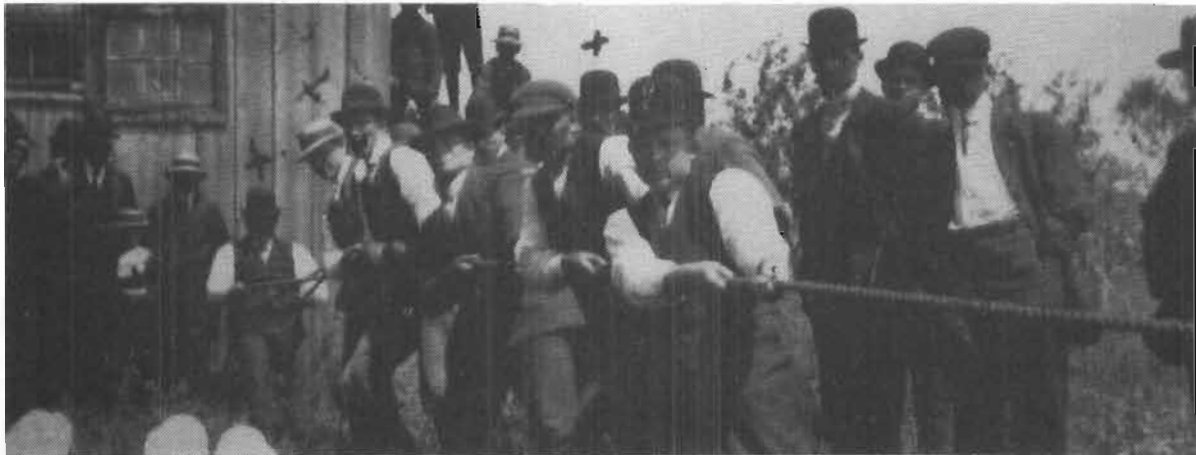
Tir au câble
