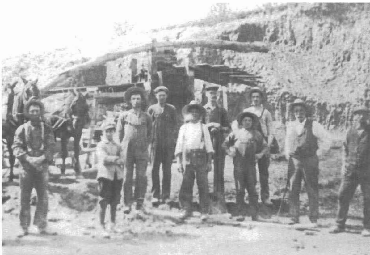
Ouvriers à l'oeuvre à la brigade
