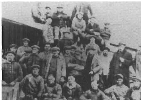
Ouvriers à la construction du pont Reid
