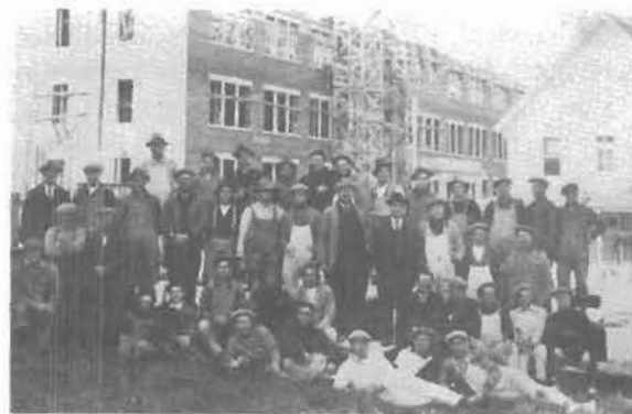
Ouvriers employés à la construction de l'École Normale
