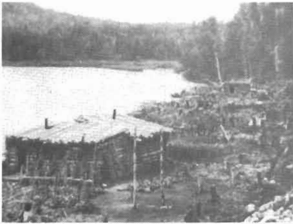
Chantier de colon
