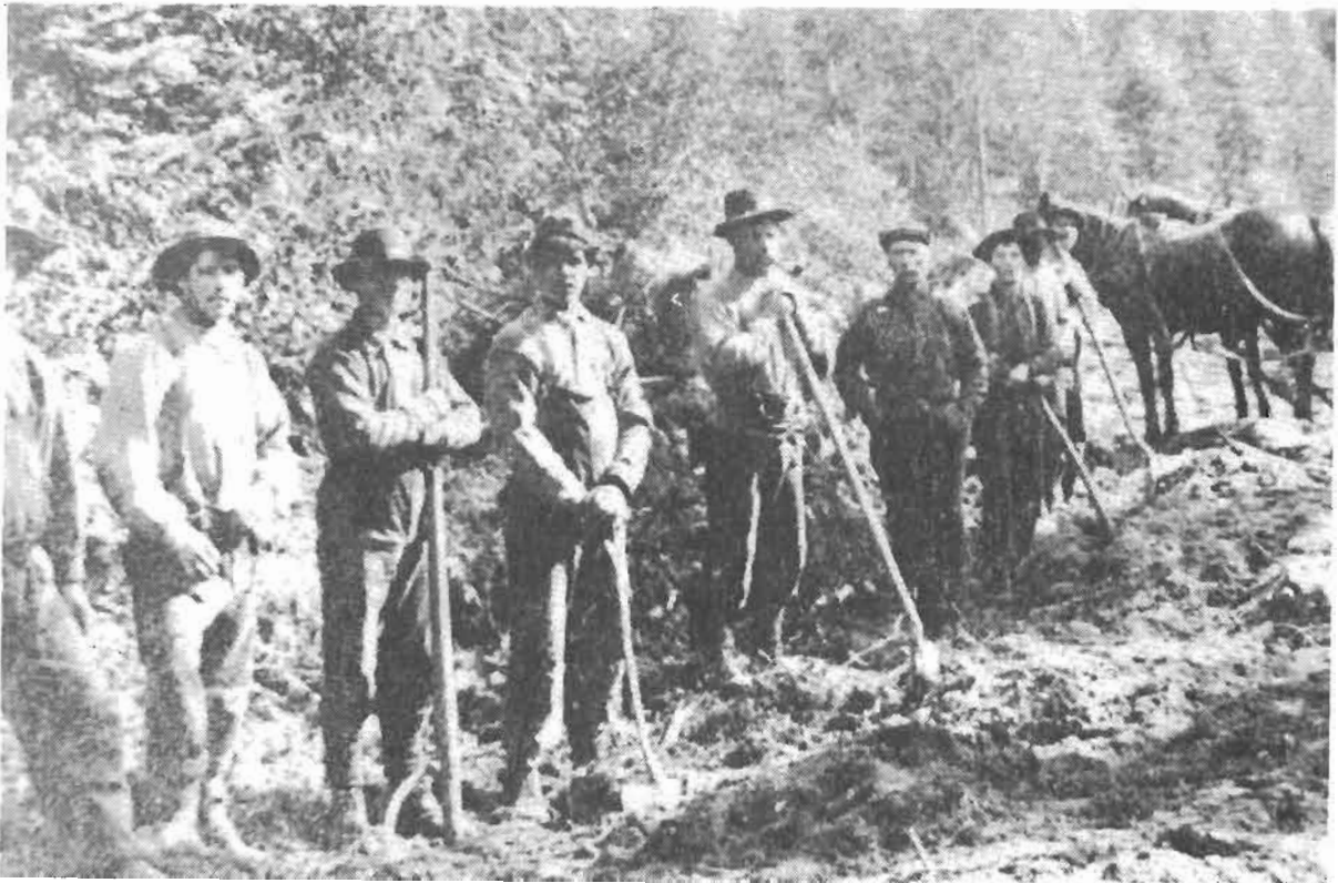
Construction d'un chemin de colonisation
