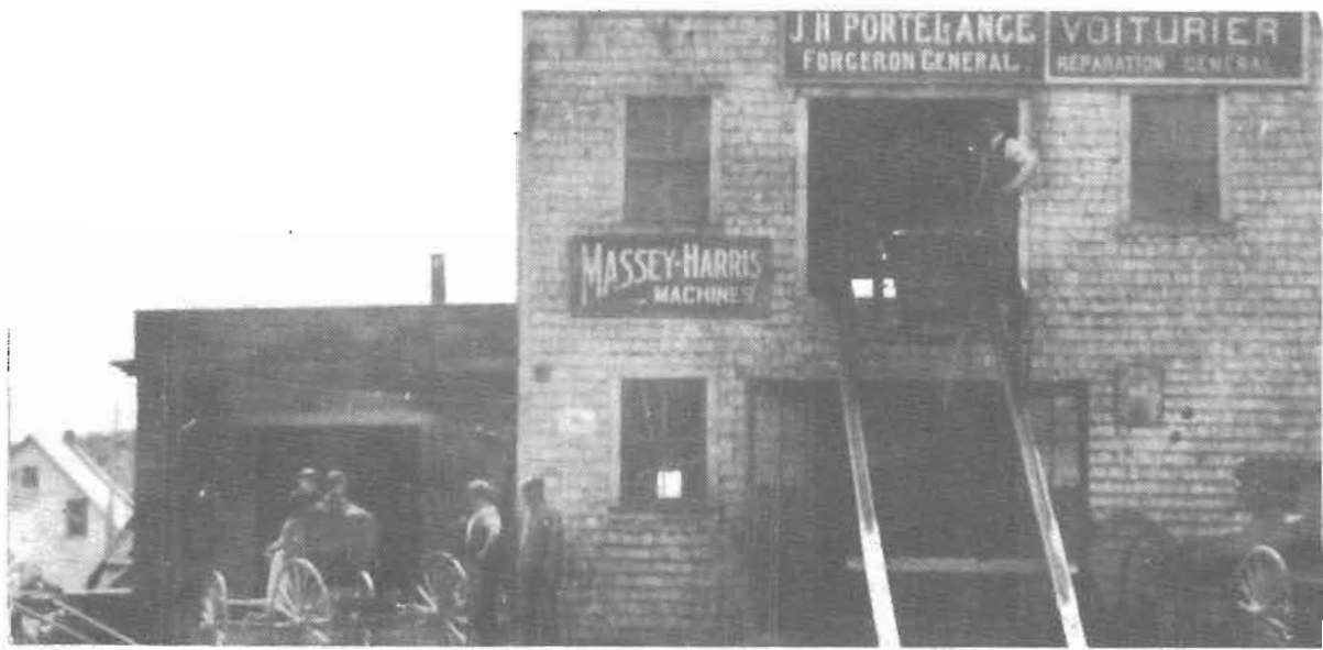
La boutique du forgeron Portelance
