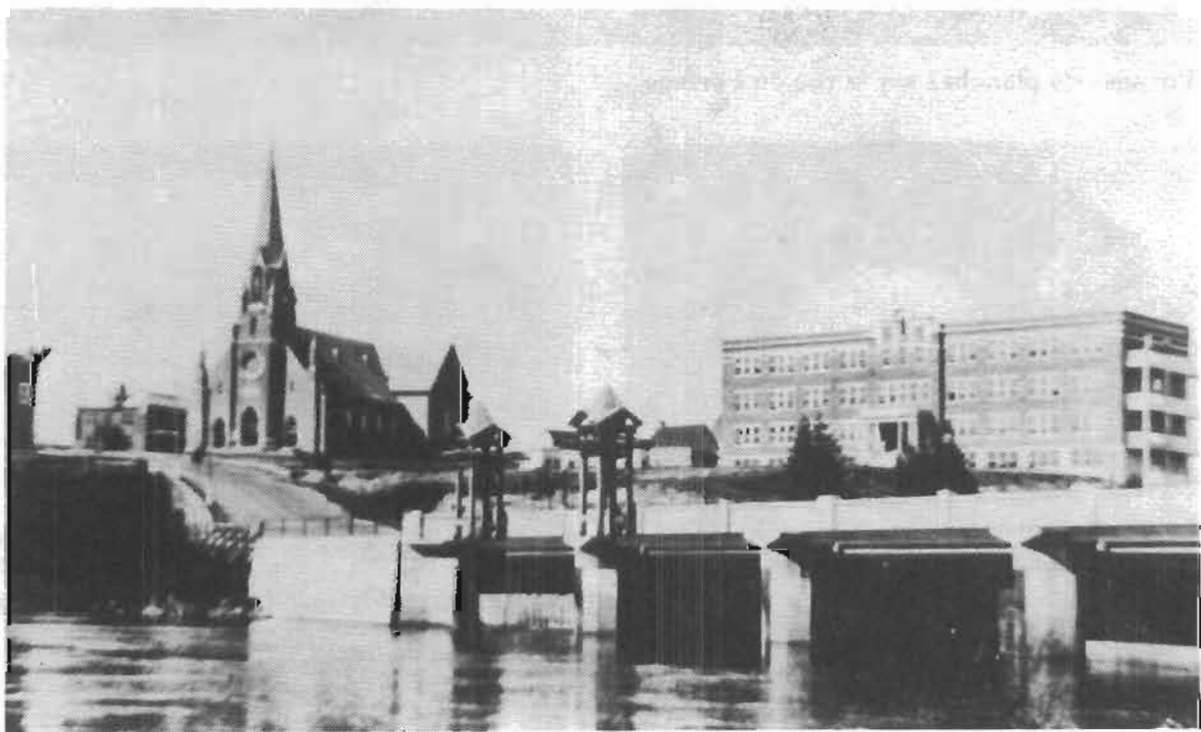
Pont-barrage de l'usine électrique de Mont- Laurier
