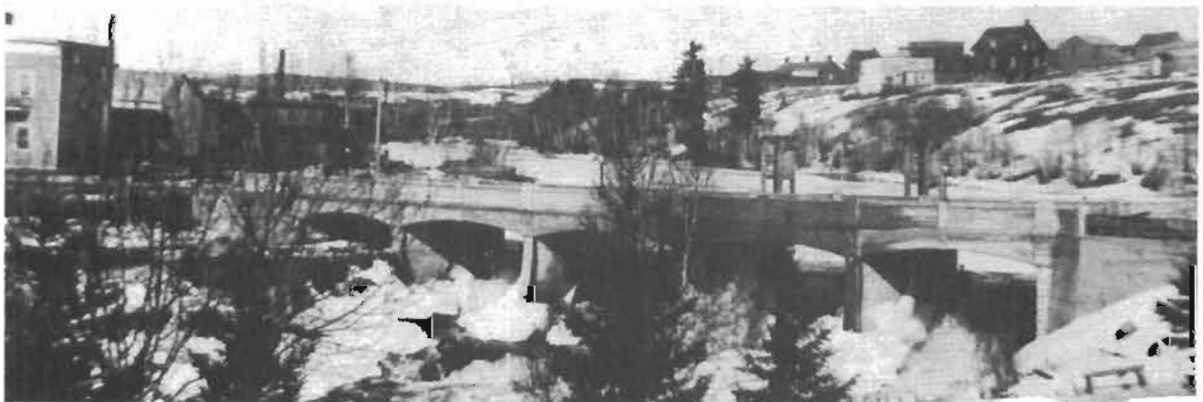
Le pont-digue sur le rapide de l'Original
