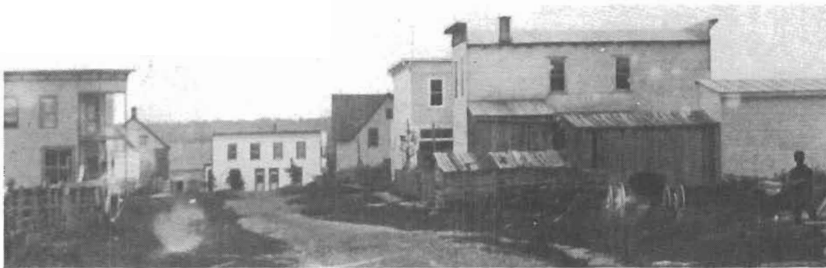
Vue de la rue Carillon
