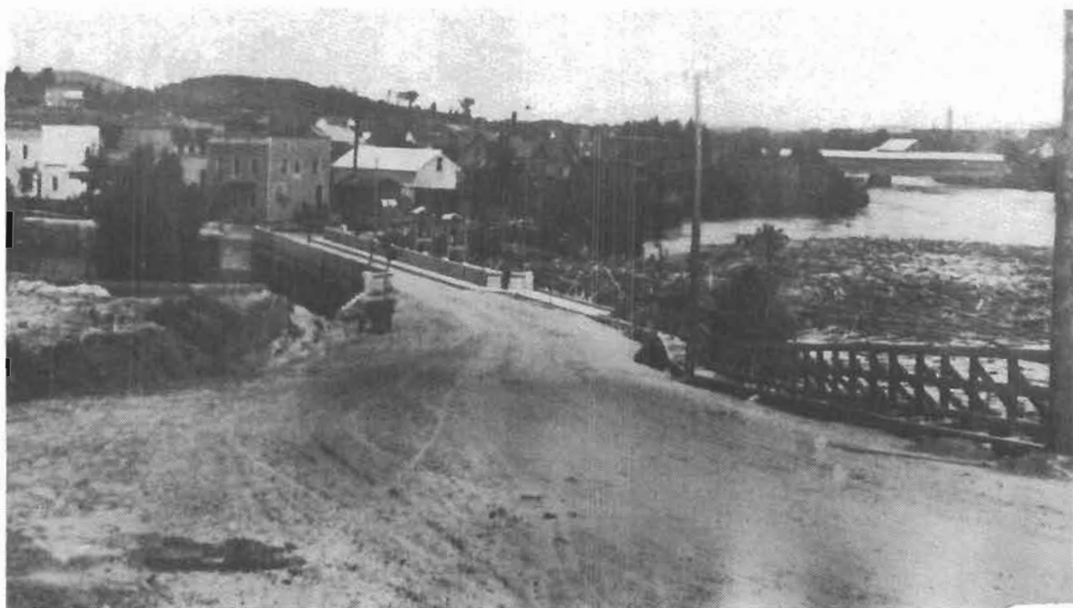
Élargissement de la rue du Pont
