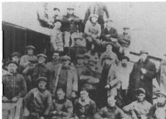
Ouvriers à la construction du pont Reid
