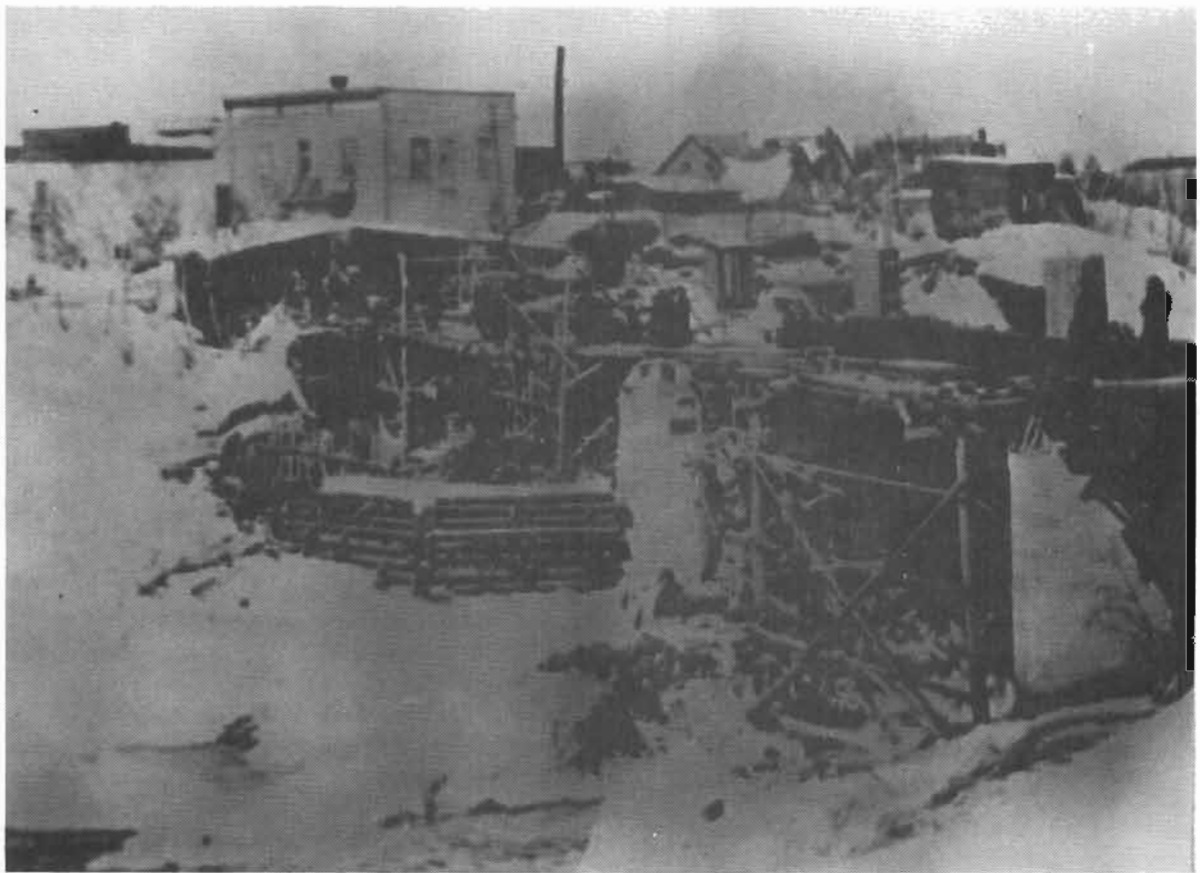
Construction du pont J.B. Reid
