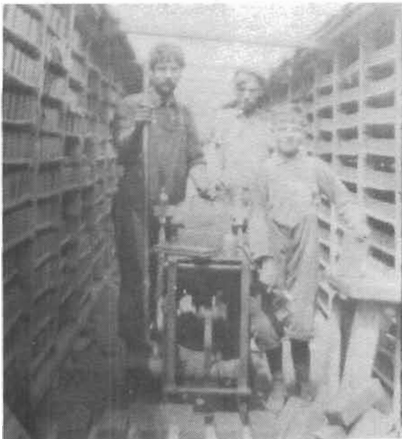
Ouvriers à l'oeuvre à la brigade
