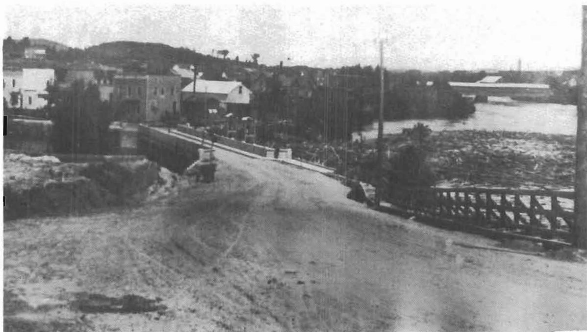
Élargissement de la rue du Pont
