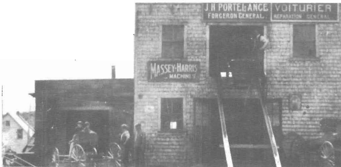
La boutique du forgeron Portelance
