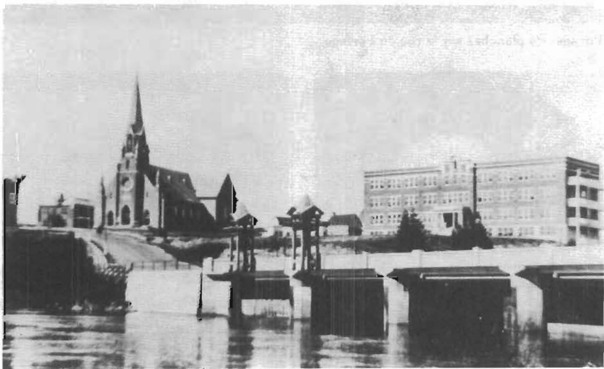
Pont-barrage de l'usine électrique de Mont- Laurier
