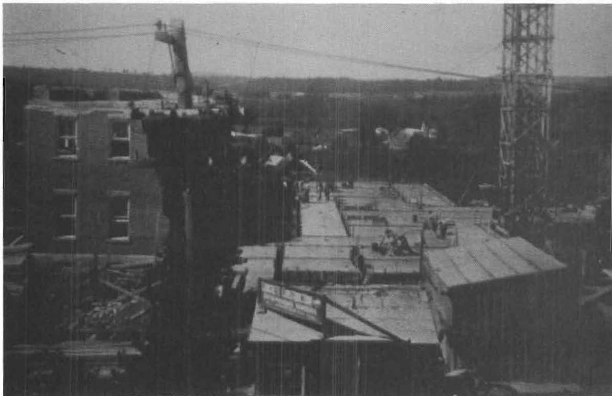
Démolition du vieux Séminaire et construction de l'Hospice Sainte-Anne
