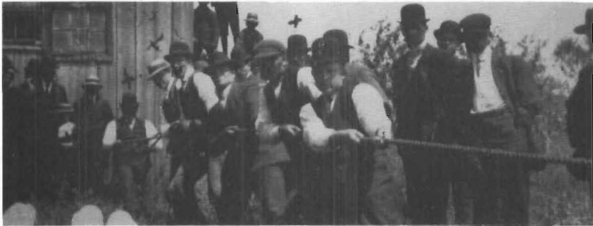
Tir au câble
