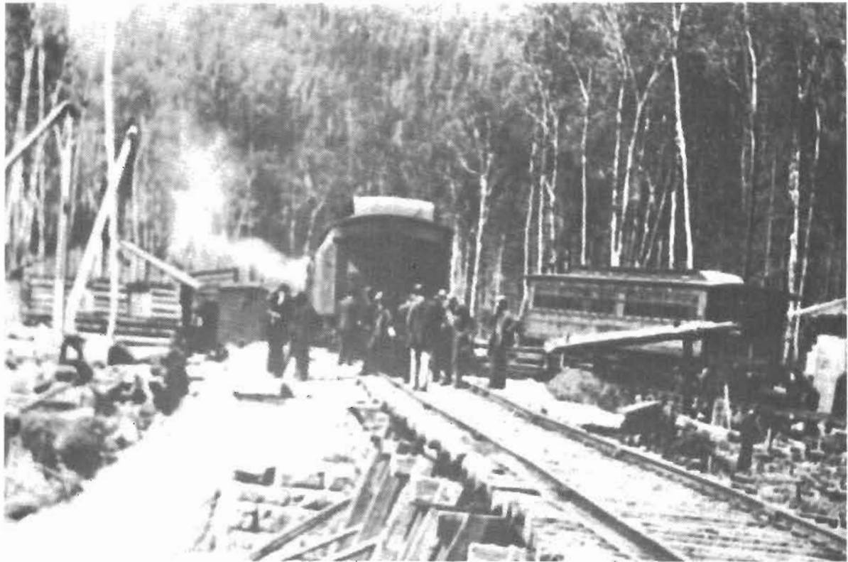
Le chemin de fer des "Pays d'en Haut" en construction
