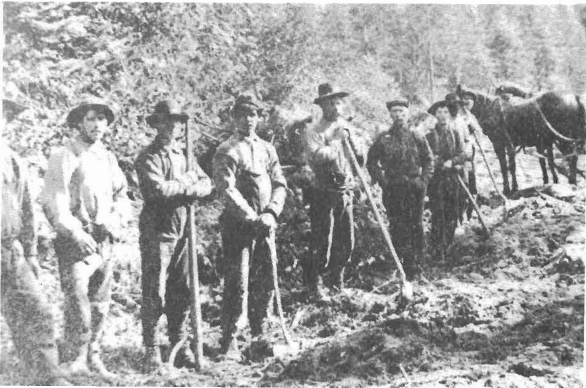
Construction d'un chemin de colonisation
