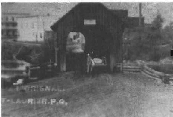
Entrée sud du pont couvert
