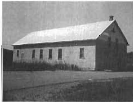
NOUVELLE SALLE PAROISSIALE.
