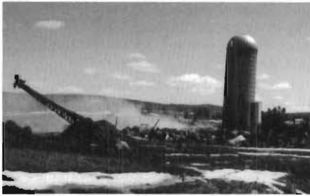
LA GRANGE-ÉTABLE DÉTRUITE PAR LE FEU EN 1989.
