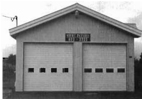
LA CASERNE DES POMPIERS CONSTRUITE EN 1990.
