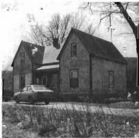
LA MAISON SITUÉE AU 88 DU CHEMIN DE LA LIÈVRE.
