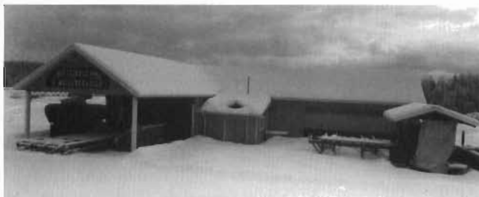
LE MOULIN À SCIE DE C. MEILLEUR & FILS INC. RECONSTRUIT EN 1993 FONCTIONNANT À L'ÉLECTRICITÉ ET AU DIESEL.
