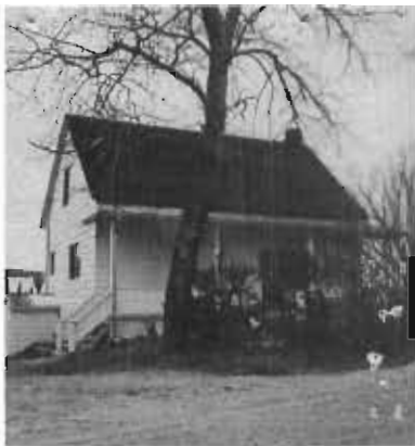
MAISON-ÉCOLE NO 3 TRANSFORMÉE EN RÉSIDENCE FAMILIALE.
