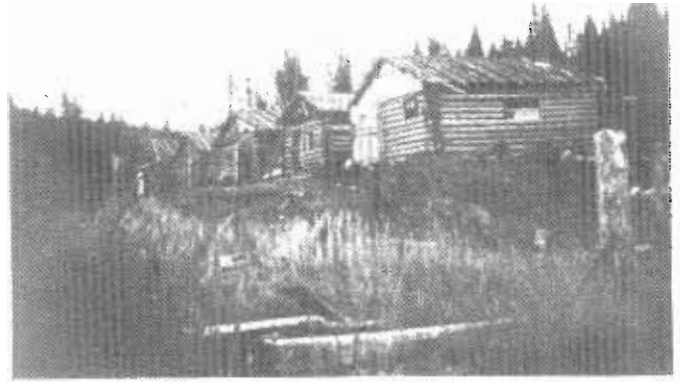
UN CHANTIER... VERS 1940.
