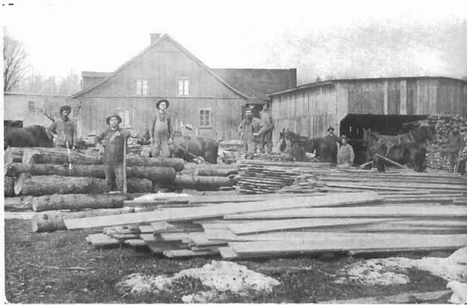
Moulin à scie, construit à l'emplacement du Moulin Bleu. 1820.
