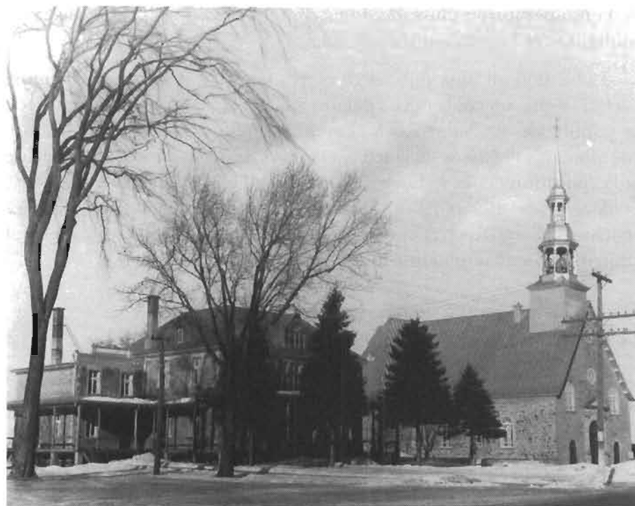
Un des joyaux architecturaux de la province de Québec et incontestablement l'une des plus belles églises de la région assomptionniste, celle de Saint-Roch-de-l'Achigan, qui a été complètement détruite par le feu, le 1 er de l'an 1958.
