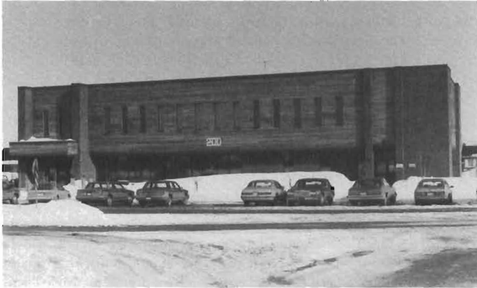
Rue Dr Wilfrid Locat, le nouvel édifice de la Caisse populaire de Saint-Roch-de-l'Achigan.
