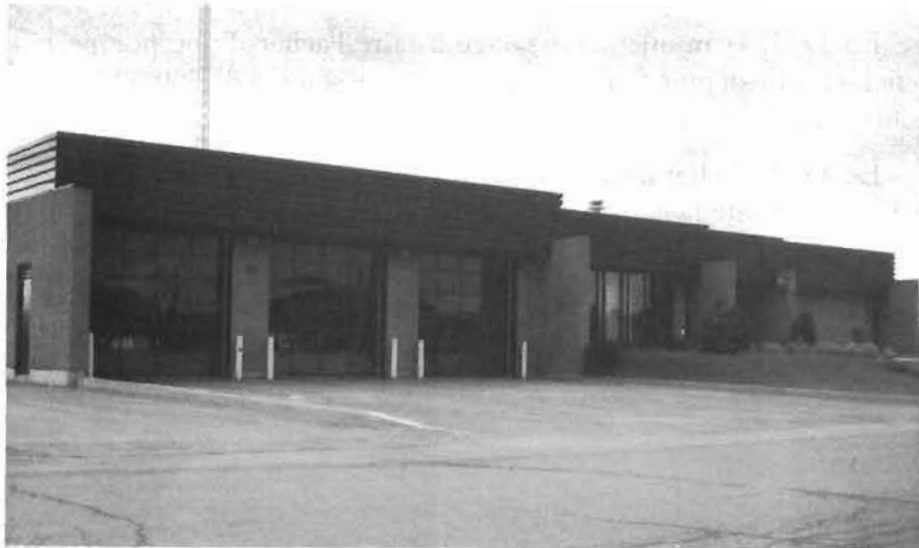
Caserne de pompiers logée à l'extrémité de l'édifice du centre administratif.
