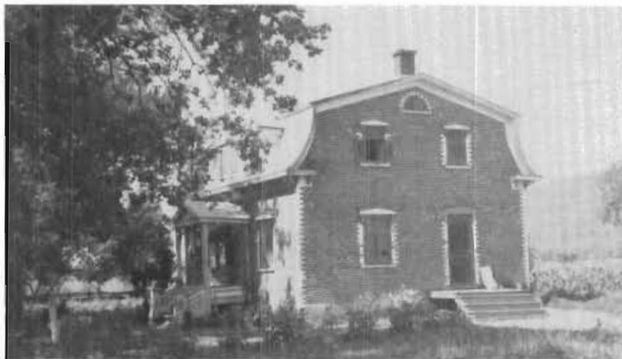
Cette maison était située au 921, 3 e rang, à St-Gabriel-de-Brandon où naquit Jean-Baptiste Dénommée en 1867. Récemment, cette même bâtisse fut démolie...
