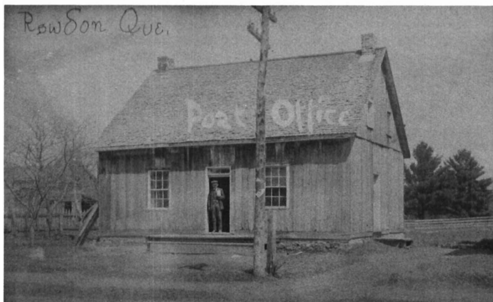
Le bureau de poste de Rawdon en 1915 sur l'emplacement du restaurant Irène sur la rue Queen
