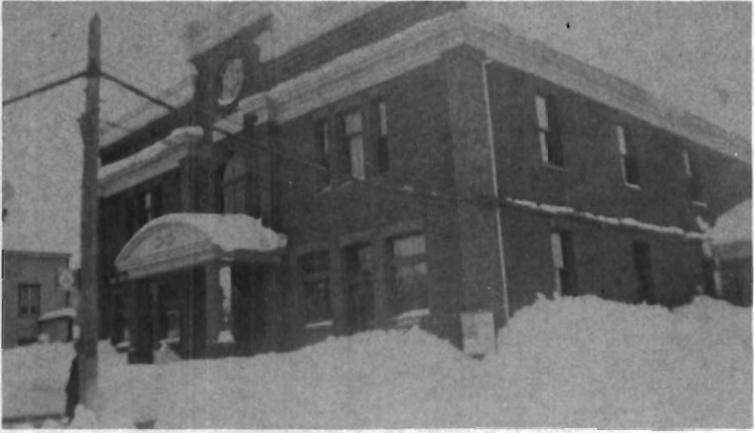
La Mairie de Rawdon construite en 1926
