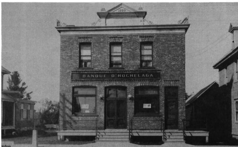
La Banque d'Hochelaga construite en 1920. Aujourd'hui la Banque Canadienne Nationale
