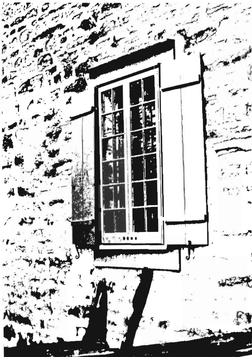
Les fenêtres sont complétées par des contrevents en planches de pin placées à la verticale et assemblées par des traverses. Les contrevents sont retenus par des crochets à volute simple ancrés dans la pierre.
