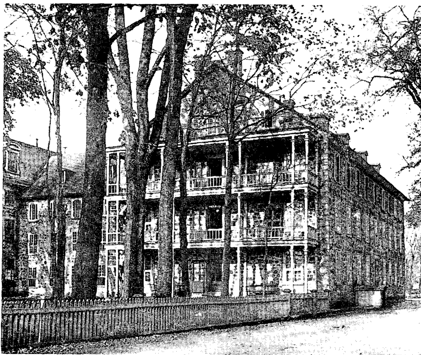
LA FONDATION DE 1832, élevée à trois étages en 1860 et démolie en 1930
