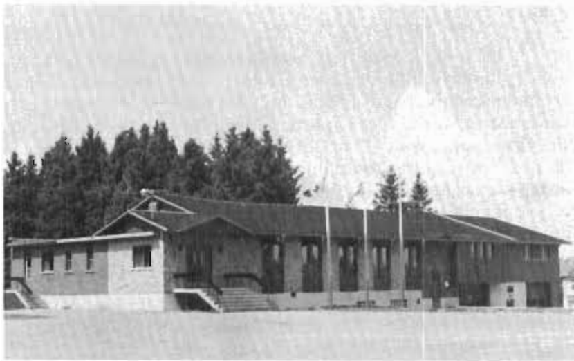
Edifice municipal où sont: Le bureau du secrétaire, la salle pour les séances du conseil, la bibliothèque, la salle paroissiale, la caserne des pompiers.
