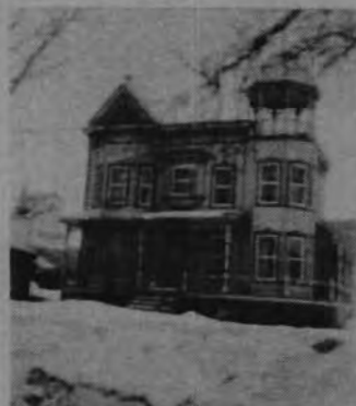
Maison d'Eugène Gadoury 110 rue Pelland
