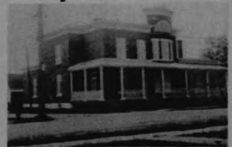
Maison d'Avila Barrette, N.P. 2313 rue Principale
