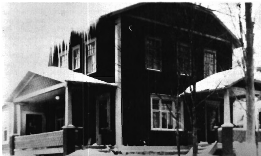
Au no. 102 rue St-Gabriel, propriété actuelle du garage M. Ernest Lafrenière, c'était le Local du bureau "Téléphone de Joliette" en 1930, maintenant démolé.
