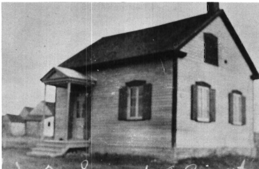
Ecole du 3ième rang déménagée sur la rue St-Cléophas.
