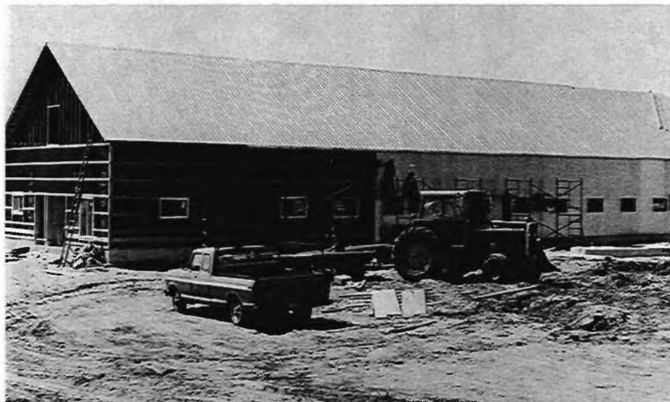
Nouveau bâtiment de M. Marcel Deschênes (en construction).
