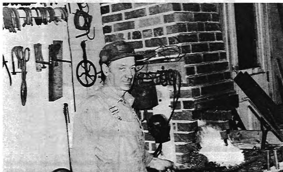
(1980).— Dans sa boutique de forge à St-Cuthbert, M. Camille Chênevert , prépare le fer, en le plogeant dans un feu ardent. (Photo Florian Aubin)
