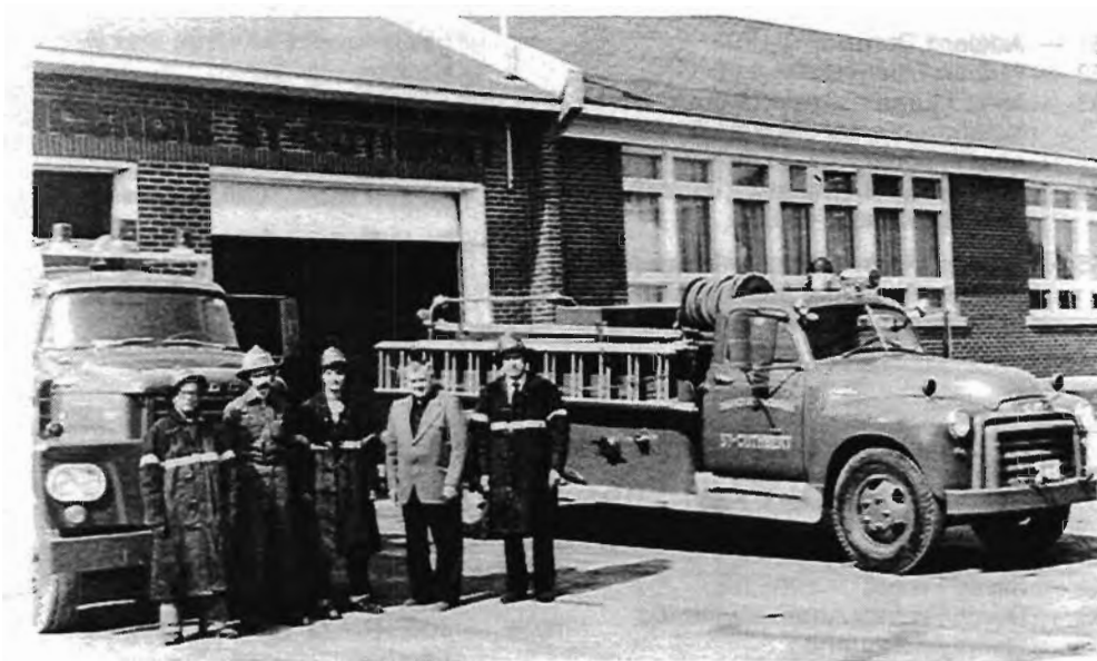
Salle municipale et Service des incendies de St-Cuthbert.
