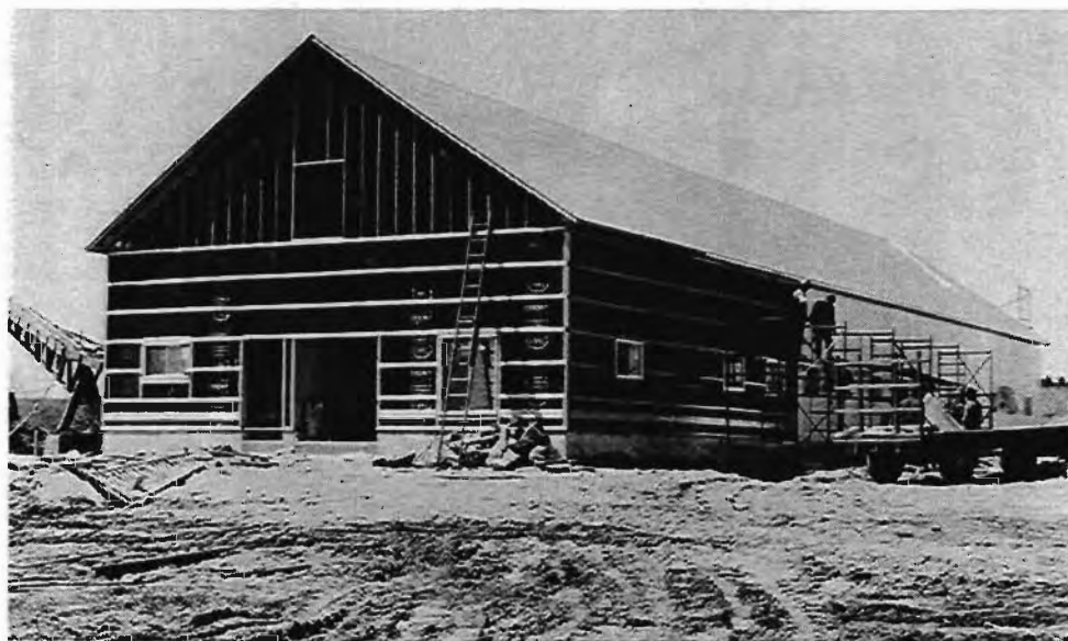
M. Marcel Deschênes remercie tous les paroissiens, parents et amis, qui l'ont aidé de quelque manière à construire un nouveau bâtiment. (Photo: Florian Aubin)
