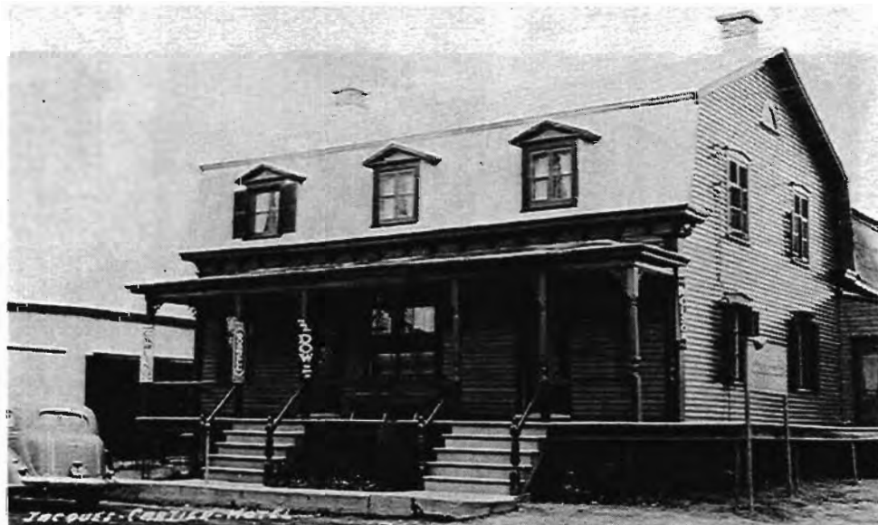
Située au carrefour de la Traverse du Moulin Avila Doucet et du Rang Chicot Nord (l'ancienne route nationale), cette maison qui fut tour à tour Hôtel et Magasin , a appartenu à Jos. Dufresne, Louis Casaubon, Jos. Sylvestre, Roméo Courchesne, Louis-Philippe Barrette, et présentement est la propriété d'Édith Lacoursière.
