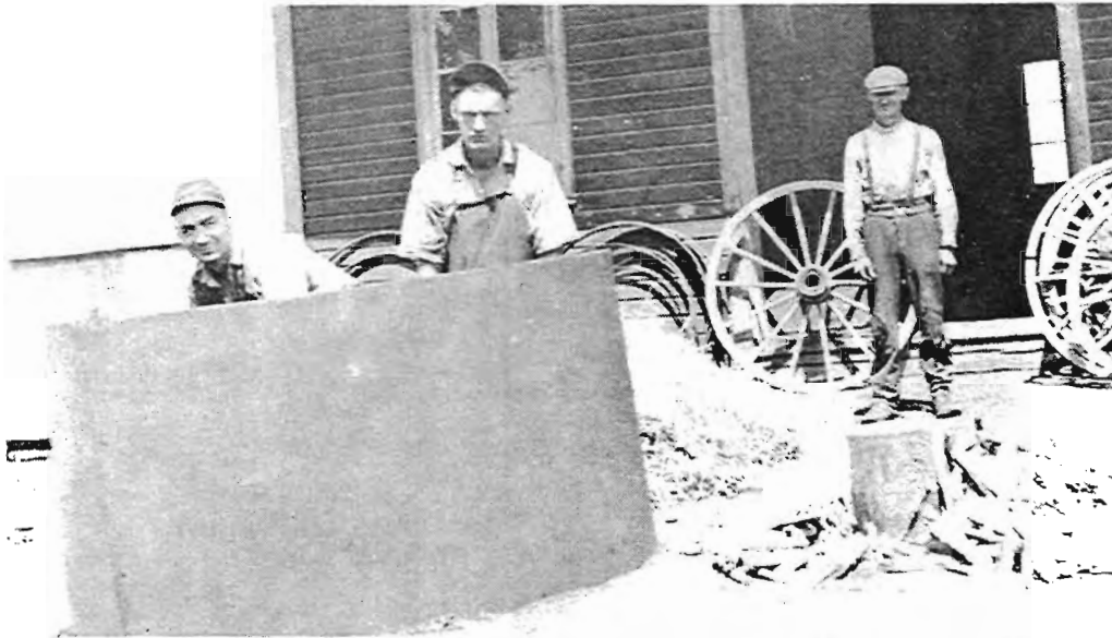
MM. Camille, Simon Chênevert, forgerons, et leur père Antoine. La 6e génération de forgerons à St-Cuthbert. À l'abri du vent, le forgeron active le feu et prépare le fer pour le bandage des roues. (Photo 1942).
