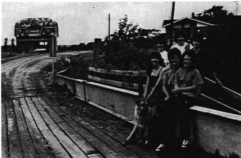
L'ancien pont St-André dans le rang des Fourches à St-Cuthbert sur la rivière Chicot, remplacé par un pont neuf. La maison de M. Ovila Dubois à droite.
