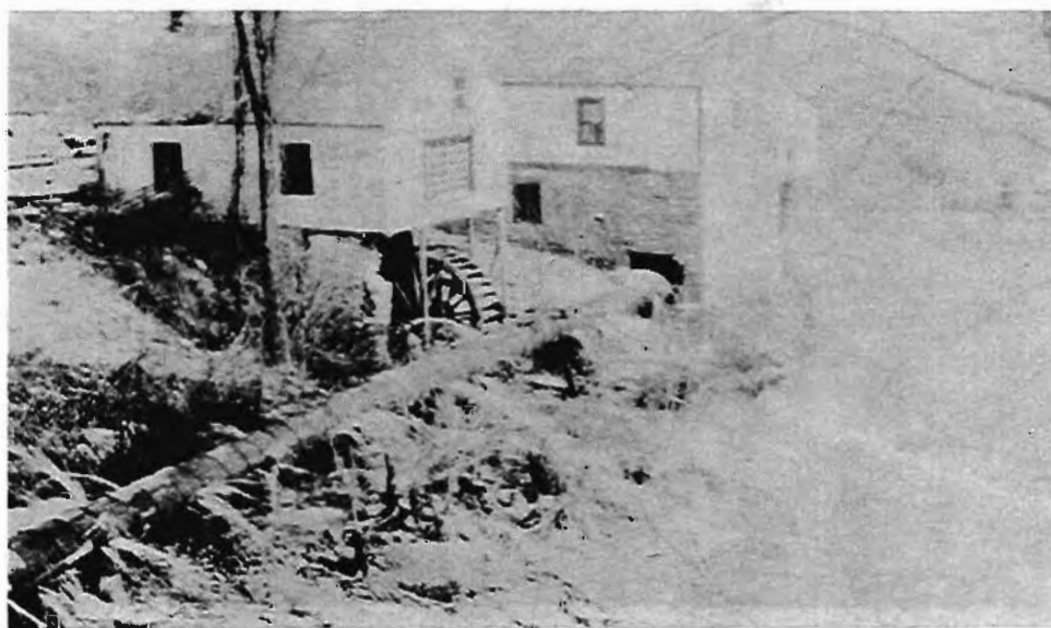
Le moulin Édouard Doucet (1928). Au premier plan le moulin à scie, et à l'arrière: le moulin à farine. Tout fonctionnait avec le pouvoir d'eau de la rivière. On voit le tuyau et la roue à aubes.
