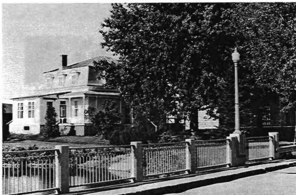
Presbytère actuel de St-Norbert, bâti en 1906.
