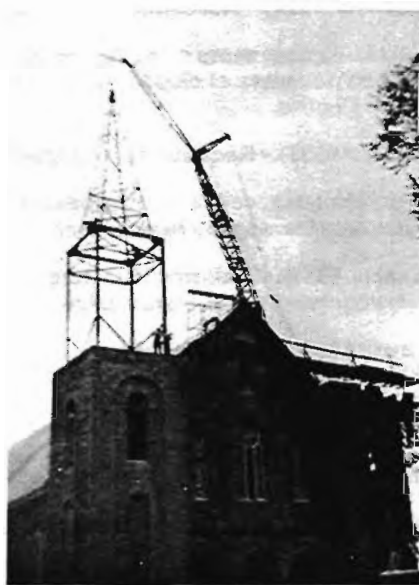
1955.- On a défilé les anciens clochers à trois étages. On fixe présentement la charpente des nouveaux clochers.
