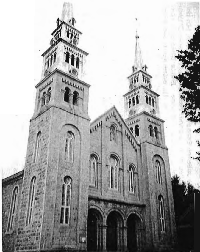
Saint-Cuthbert. "Une splendeur perdue". Façade tripartite en pierre de taille avec raccordement au pignon, qui rappelle celle de Lavaltrie. François Archambault, entrepreneur, d'après les plans de Victor Bourgeau. (1879).
