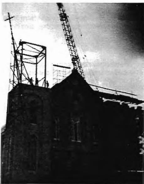
1955.- On a défilé les anciens clochers à trois étages. On fixe présentement la charpente des nouveaux clochers.
