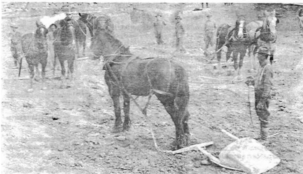
Pour la construction de routes, de nivellement de terrain. etc., nos ancêtres se servaient de moyens rudimentaires, de pelles à chevaux , de pics... avant l'arrivée des pelles mécaniques puissantes et des béliers géants.
