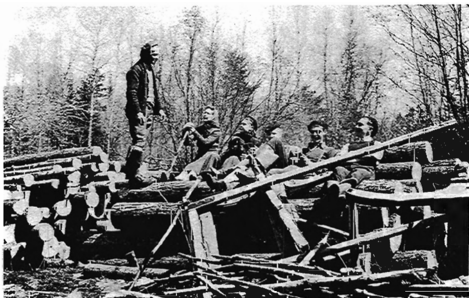
Haut: Moulin à scie, chez M. Delphis Dufresne (vers 1925). Bas: Moulin à scie, chez M. Georges Maréchal (vers 1940).
