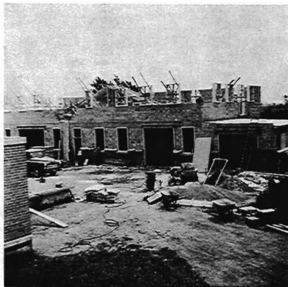
Pavillon du Génie rural, en construction (1959).
