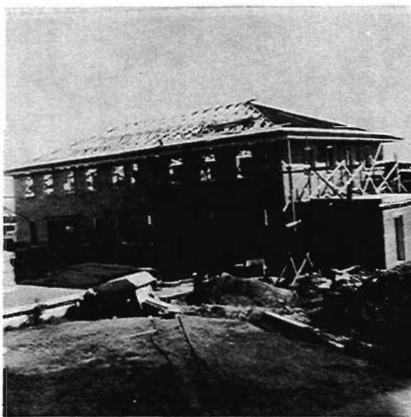
Le Nouvel Atelier (75 pieds X 40 pieds) à 2 étages, en construction (1959).
