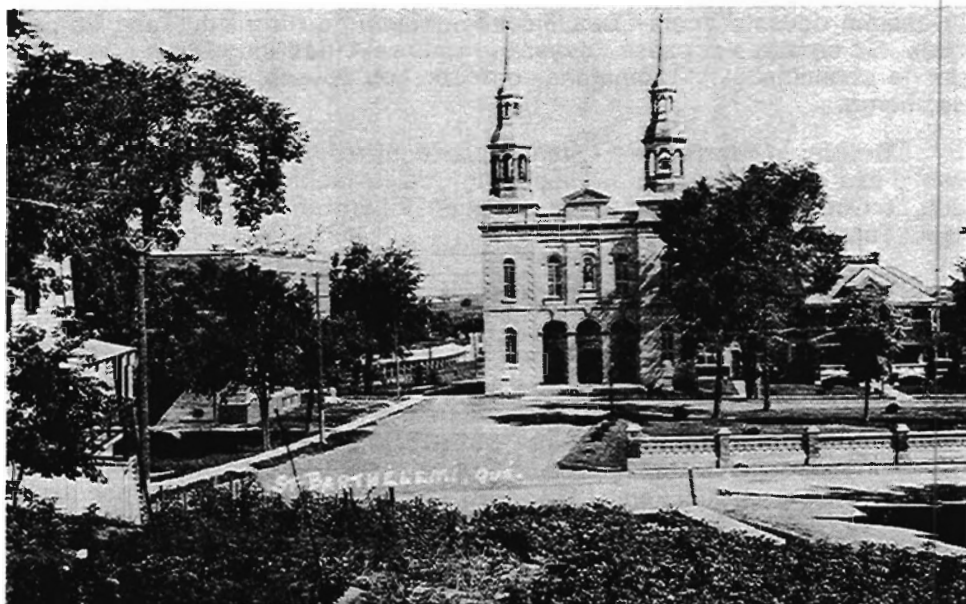
Vue de la Place St-Barthélemy : clôture, parterre, église et presbytère.
