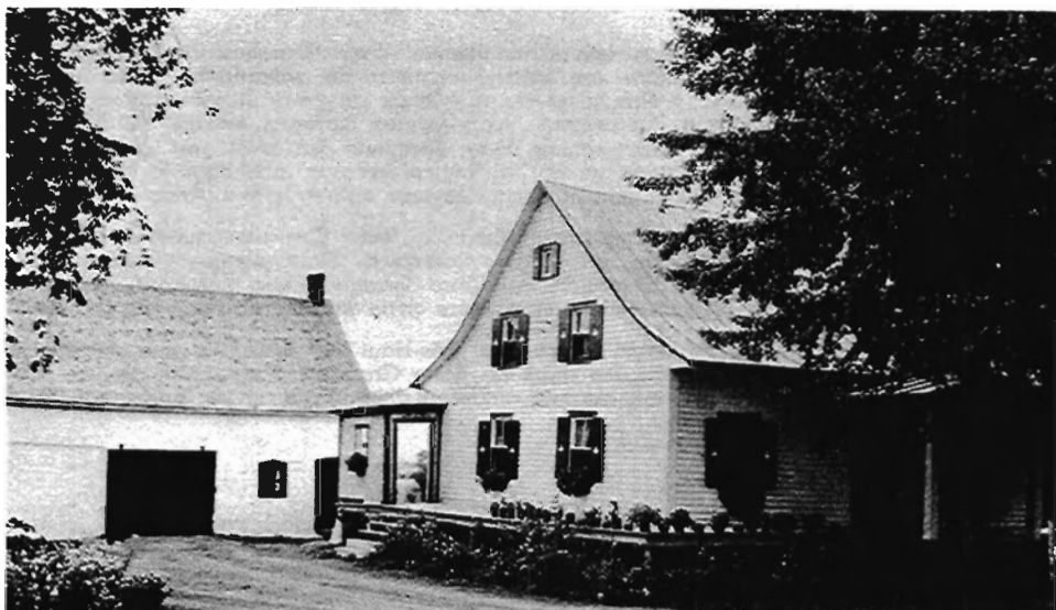
Maison bâtie en 1850 par M. Louis Michaud, signataire de la requête
