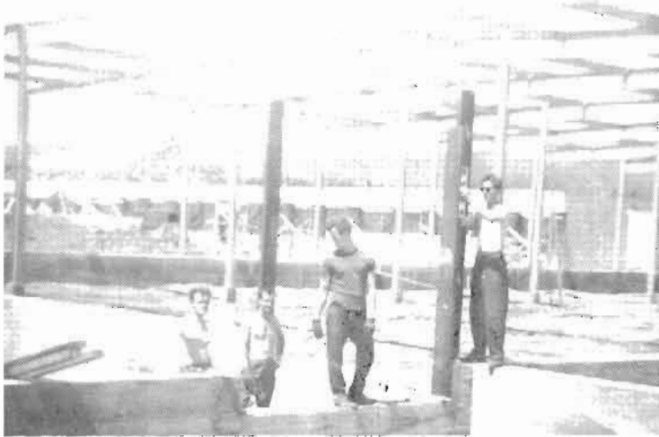
Pendant la construction de la nouvelle manufacture en 1959.
