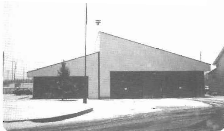
Bureau municipal et garage pour le camion à incendie. Construit en 1980.
