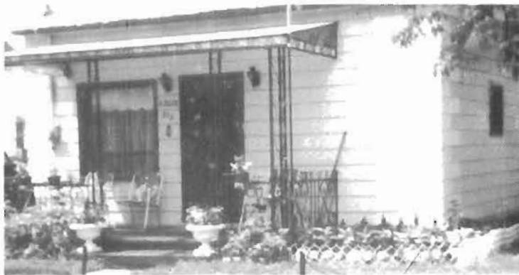
Maison qui était construite pièces sur pièces jointes avec de la boue et des poches de jute... Elle a été complètement rénovée.
