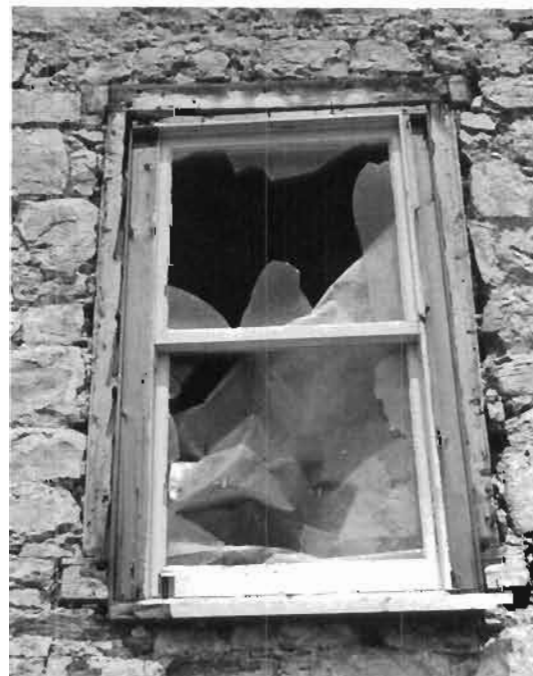
Prototype d'un cadre de fenêtre. Le faux-cadre a été diminué à la hache et l'allège coupée pour faire place à la nouvelle fenêtre.
