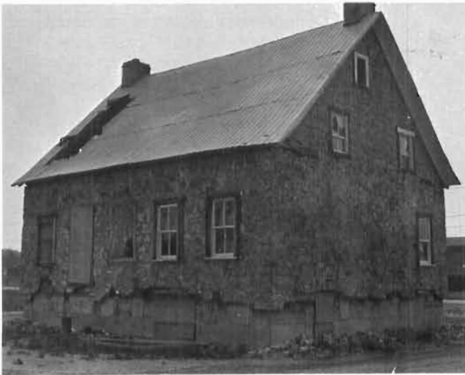
La façade arrière de la maison avant et après restauration
