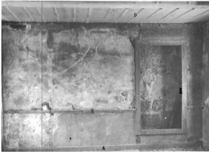
État du mur ouest après le curetage A) Plinthe B) Cymaise
