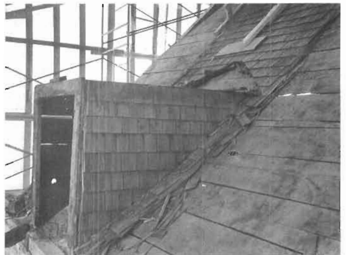
Le curetage d'une lucarne. Remarquons la forme première du toit de la lucarne dans le bardeau de la toiture.
