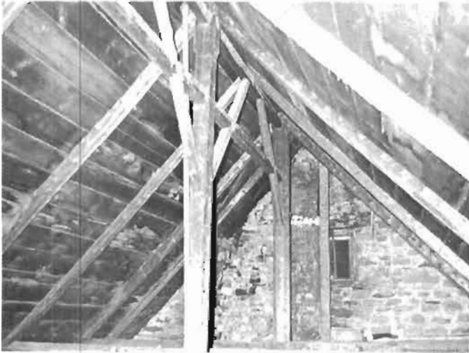
Une partie de la charpente.
