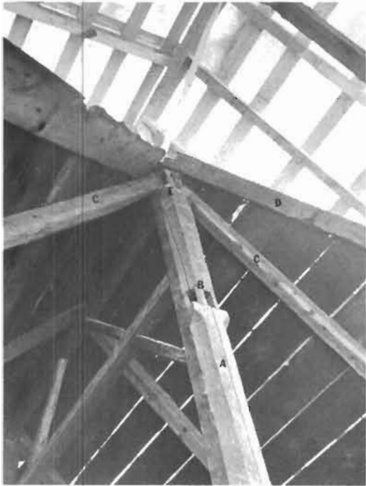
Photo explicative de l'un des deux poinçons comportant des mortaises
