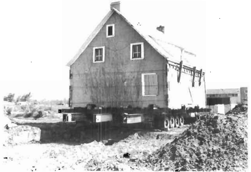
La maison sur son nouvel emplacement. Le poids de la maison était environ de 350 tonnes
