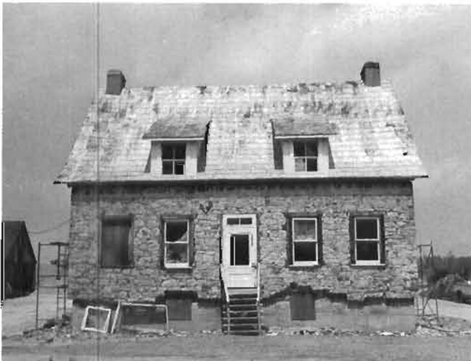
Façade principale de la maison après le curetage. Sur la photo, le solage est fait de béton, et sera recouvert de pierre
