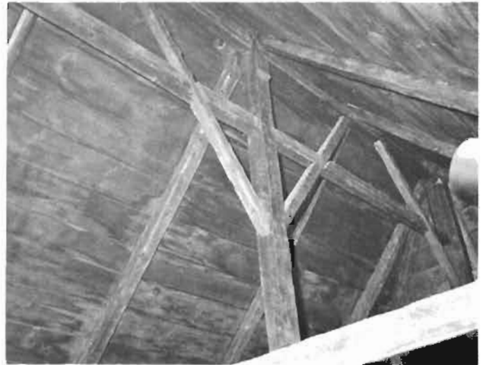
Détail de la charpente sur le poinçon central
