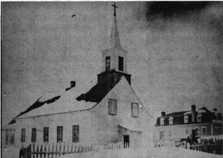
La Chapelle de Saint-Odilon de Cranbourne, construite en 1859, sous le mandat de l'abbé Odilon Paradis.
