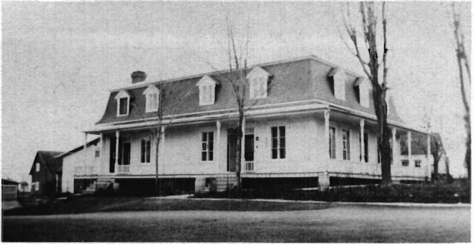
Presbytere de Saint-Odilon avant sa démolition.
