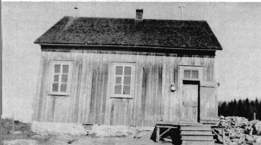
Des fondations jusqu'à la terre ferme, un *solage* [sic] d'au moins un pied en mortier.
