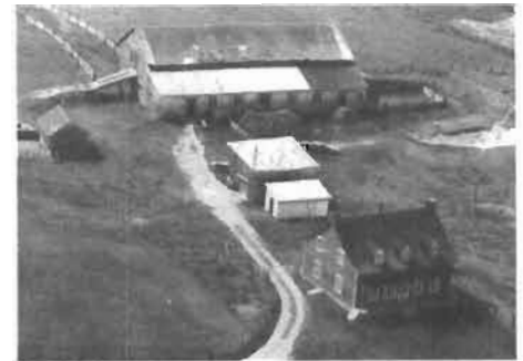
Résidence des ancêtres Gagné construite en 1860. Cette terre des Gagné a été occupée de père en fils et ce depuis Louis Gagné, marié à Scolastique Lessard en 1758.
