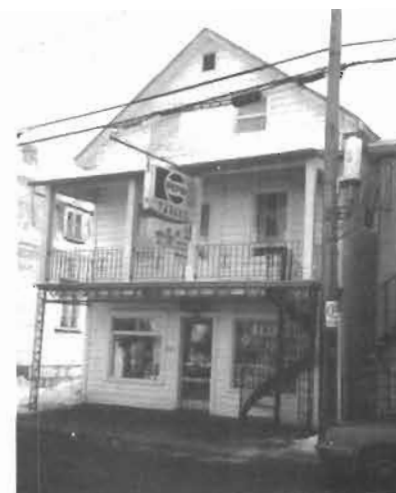
Maison abritant le commerce sur l'avenue du Palais
