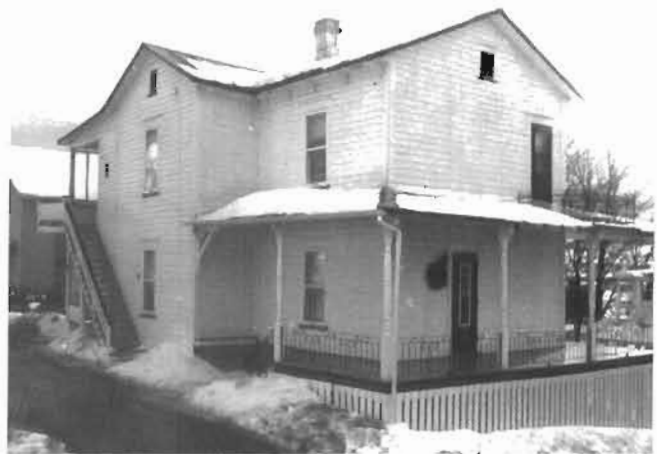
Maison située au 122 de la Gorgendière.
