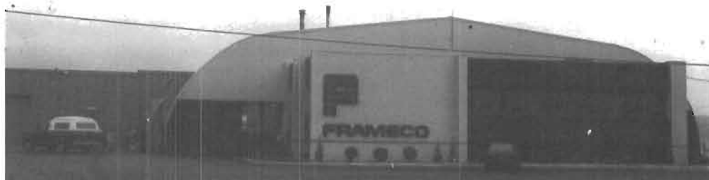
Manufacture Frameco Ltée
