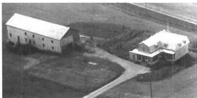
La ferme avant les réparations
