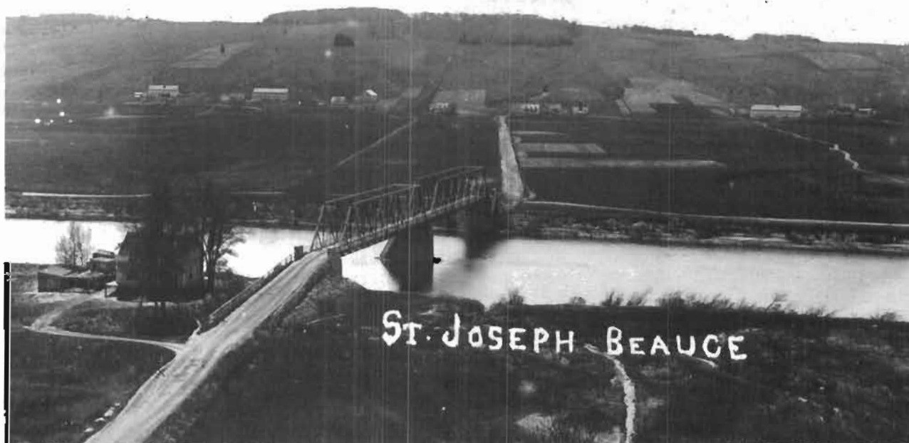
1912: Vue aérienne du pont et du coteau ouest
