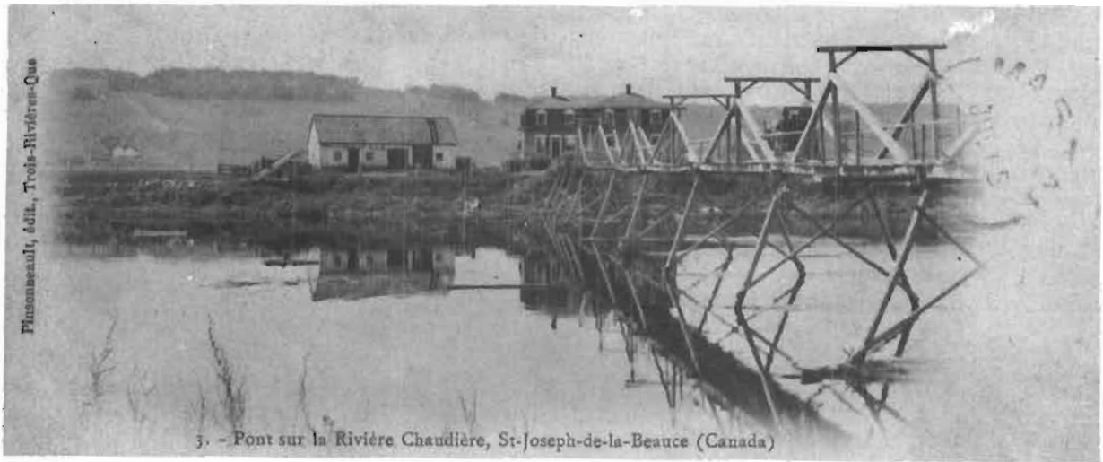
Le pont de bois sur chevalets utilisé de 1847 à 1908
