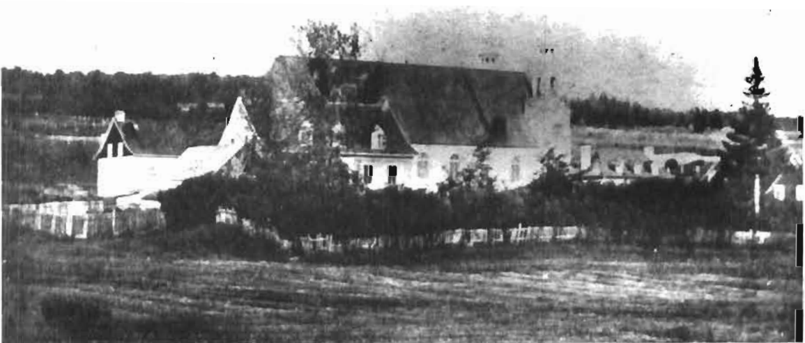
La deuxième église de Saint-Joseph, incendiée en 1864. À remarquer les deux clochers
