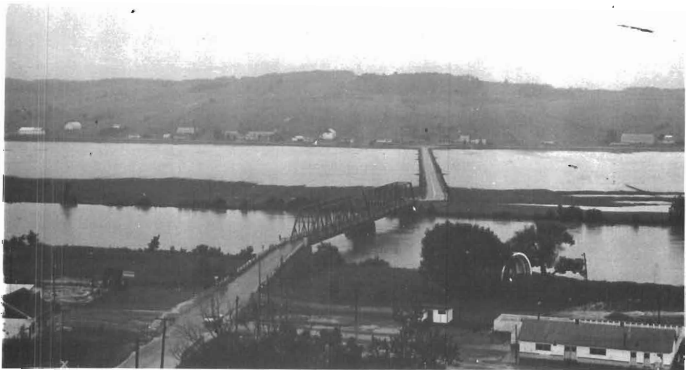
Le pont de fer inauguré le 4 juillet 1909
