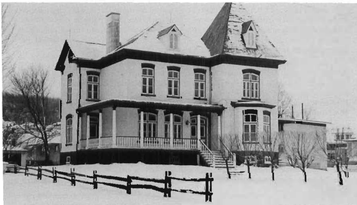
Résidence du notaire F.-G. Fortier, 218 ave Lambert, déjà habitée par Léandre Bernard. Don du Patrimoine des Beaucerons.
