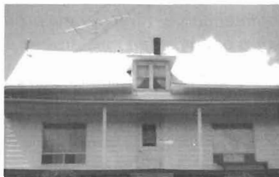
Vieille maison rénovée
