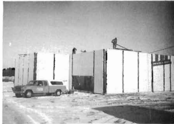
Construction de l'empileuse
