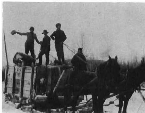
Omer Pomerleau guide ses chevaux, dans les chemins de chantiers. Voiture à glacer, empêchant les chevaux de caler.
