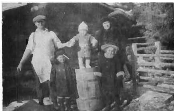
Montons aux chantiers... en famille.
