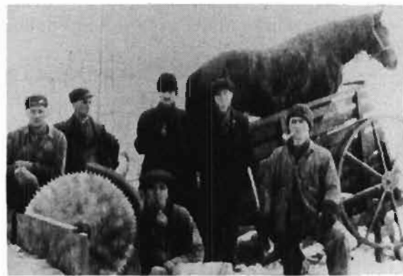
Coupe du bois de chauffage à la scie ronde actionnée par un cheval.
