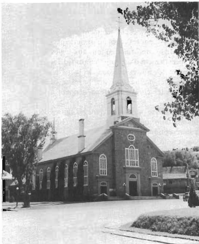
Église actuelle en 1953. Végétation, perron, cheminées, école presbytérale. A.N.Q., O.F.Q. 95650-53.
