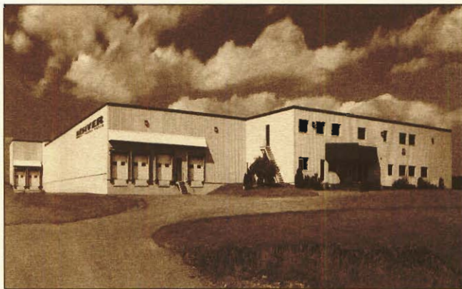
Usine A (181 e rue)
