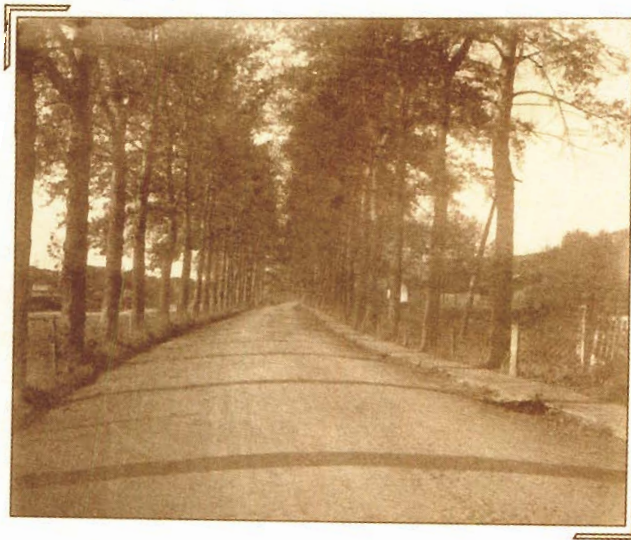
Vers 1930, l'entrée Sud de Beauceville-Est, le long de la Chaudière. Trottoirs de bois et allées majestueuses d'ormes, à l'orée du Bois des Amoureux. (Fonds André Garant)
