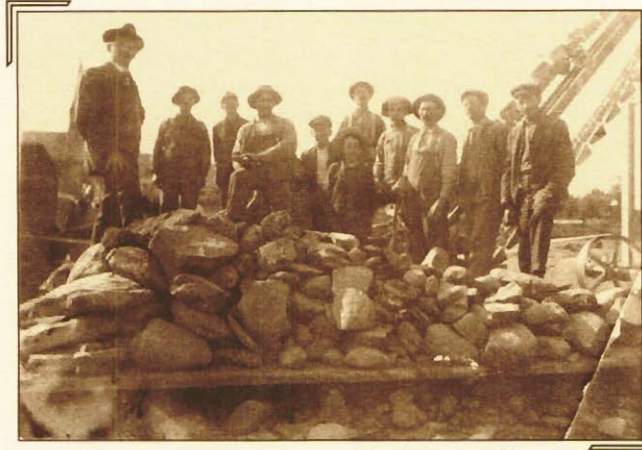
Travaux routiers au centre - ville de Beauceville-Est, le 24 septembre 1913. (Fonds André Garant)
