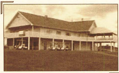
Le « club house » du golf construit en 1992
