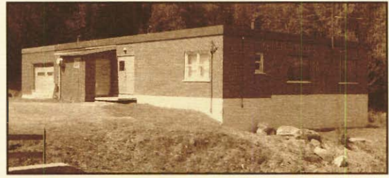
Usine de filtration construite en 1964 située en bordure de la rivière du Moulin. Sera remplacée par une nouvelle usine qui sera située sur la route 108 à l'Ouest de l'hôpital.
