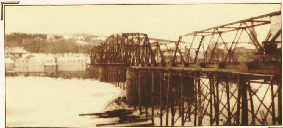
La construction du Pont Fortin (Fonds Mme Rollande Veilleux)
