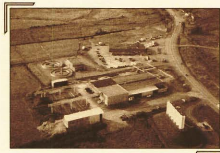
Vue aérienne usine d'épuration
