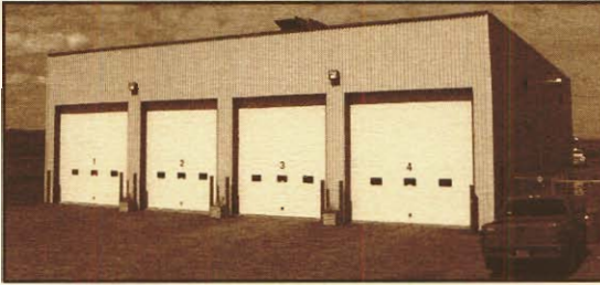
Garage municipal situé dans le parc industriel construit en 2000. On y retrouve aussi l'entrepôt à sel et le site de dépôt à neige (à proximité).
