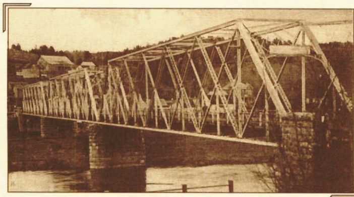
Le 1 er pont de fer sur la Chaudière 1899-1932... à Beauceville. (Livret-souvenir du notaire Philippe Angers, 1932)
