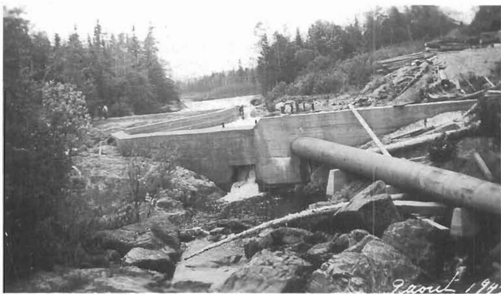
Le barrage en amont du même moulin fournissant la force hydraulique nécessaire à son fonctionnement.
