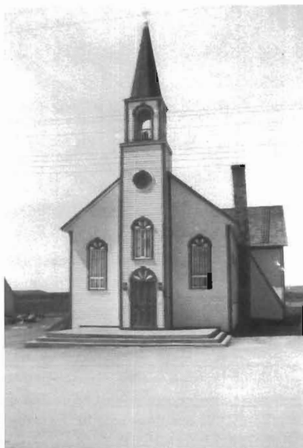
La vieille église juste avant sa démolition.
