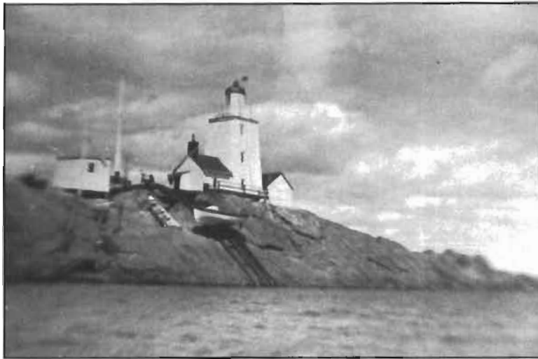
Le phare des Islets de Bellechasse construit en 1863, puis détruit en 1964 par ordre du ministère des Transports.
