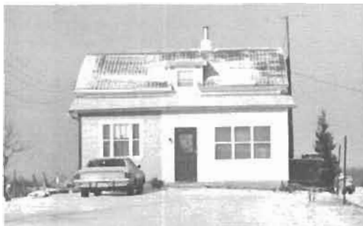
Maison bâtie en 1956, vue du chemin du rang 2
