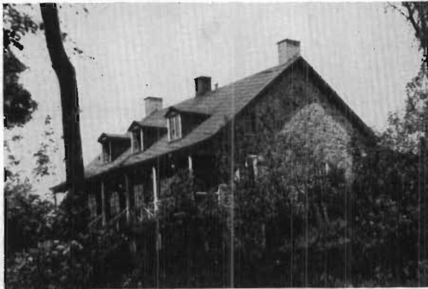
ANCIENNE ÉCOLE PAROISSIALE (1893-1911)
