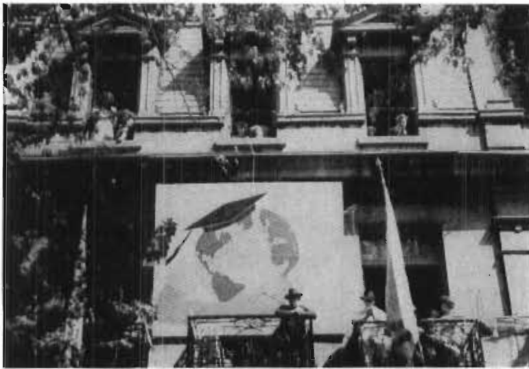
LA CENTRALE RUE SHERBROOKE
