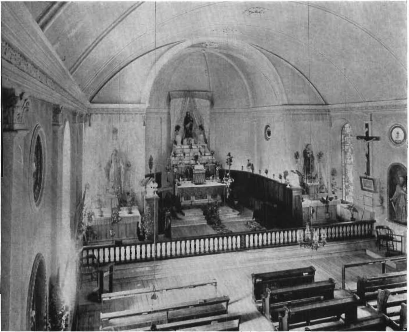
LA CHAPELLE CONSTRUITE EN 1863 À remarquer : la verrière de droite.
